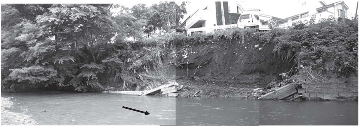
写真-3 被災状況
