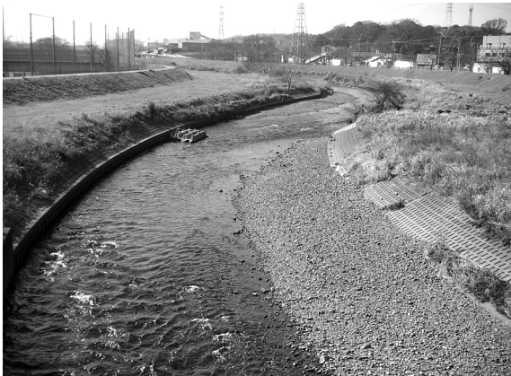
写真-2 柳瀬川下流部（ふれあい橋付近）
