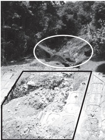
写真-7 崩壊したプレキャスト法枠と、上部にある不安定土塊
