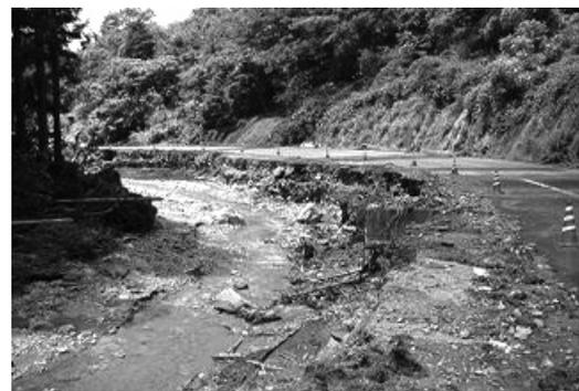
写真-3 破損した兼用護岸
