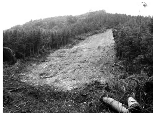
写真-4 表層が崩壊した斜面
