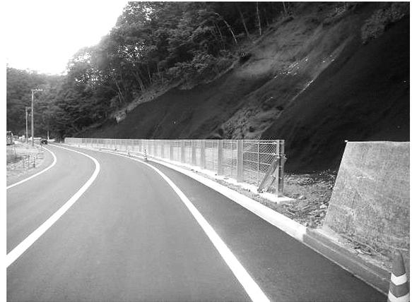
写真-8 法面復旧及び落石対策工施工後
