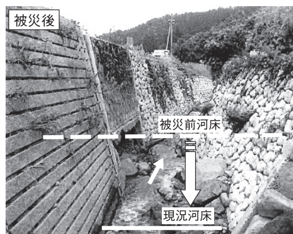
写真-1 河床低下 (被災前と被災後の比較)
