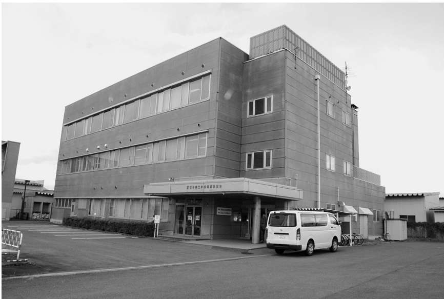
(財)岩手県土木技術振興協会 全景
