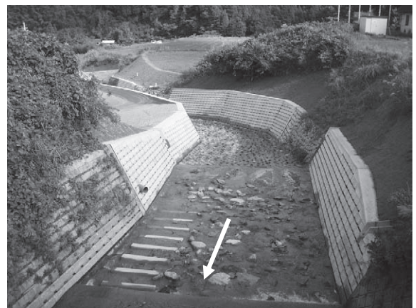
写真-3 完成写真
