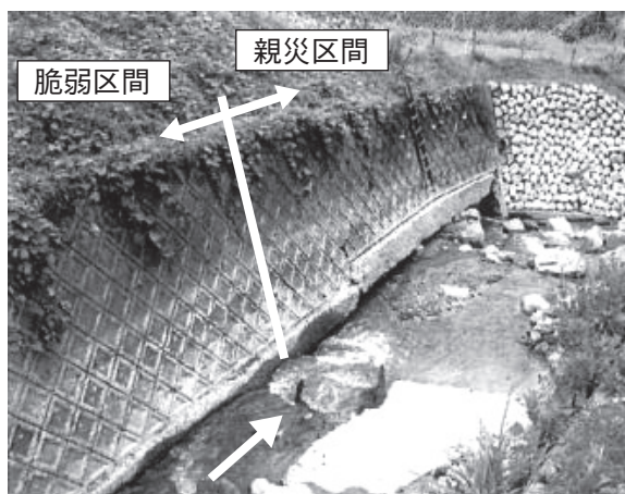
写真-2 脆弱な未被災護岸
