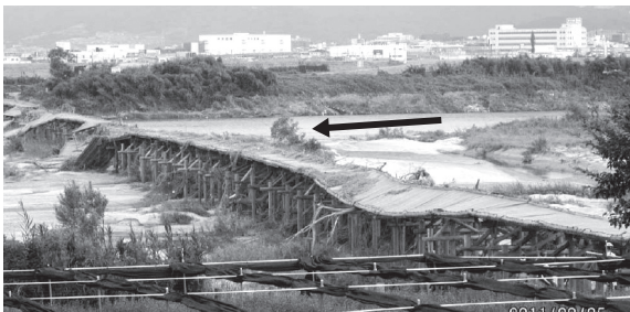
18回目の被災(左岸側から)
