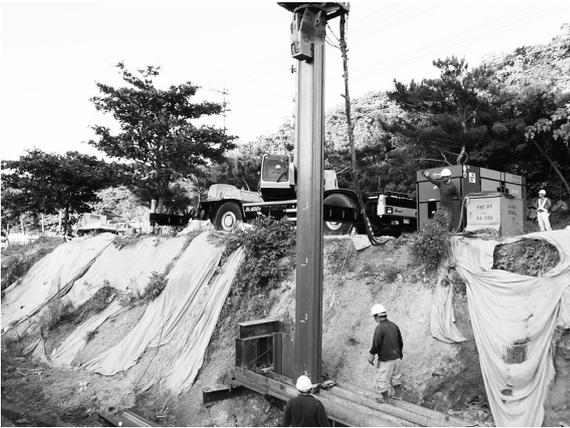
写真－5 鋼矢板打込状況
