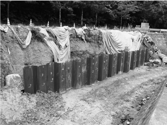
写真－6 鋼矢板打込完了
