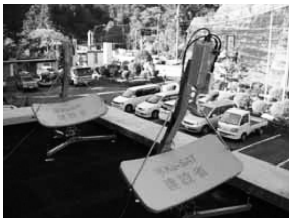
写真-3 Ku-SAT の設置状況
