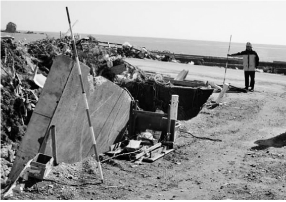
写真－1 道路の被災状況調査
