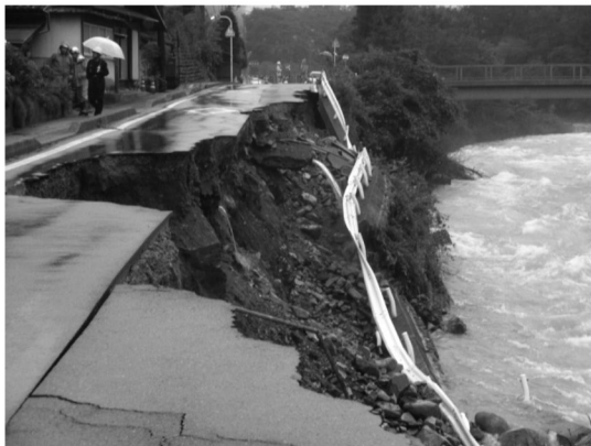
岐阜県 下呂市 小坂町 一般県道湯屋温泉線(法面崩壊)
