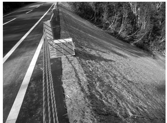
写真－3 復旧工事完成
