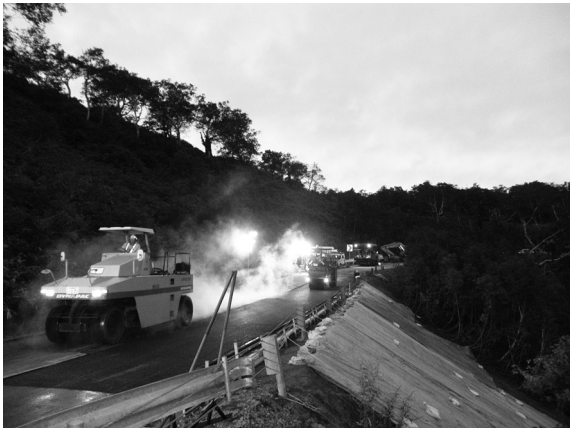
写真－2 夜を徹した復旧工事
