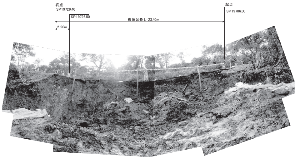
写真-1 被災状況（崩壊下から道路を望む）
