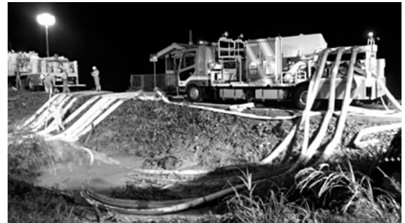
写真－2 排水ポンプ車稼働状況
