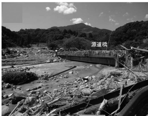
和歌山県 那智勝浦町 井関地区(河道閉塞)
