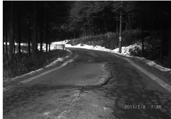
舗装面の亀甲状クラック及び盛上がり、沈下(岐阜県)
