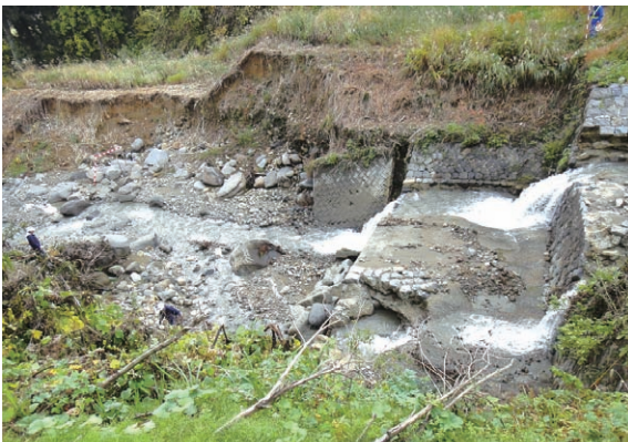
一級河川鎌倉沢川 かまくらさわ （洪水による砂防堰堤等の被災状況） (新潟県南魚沼市)
