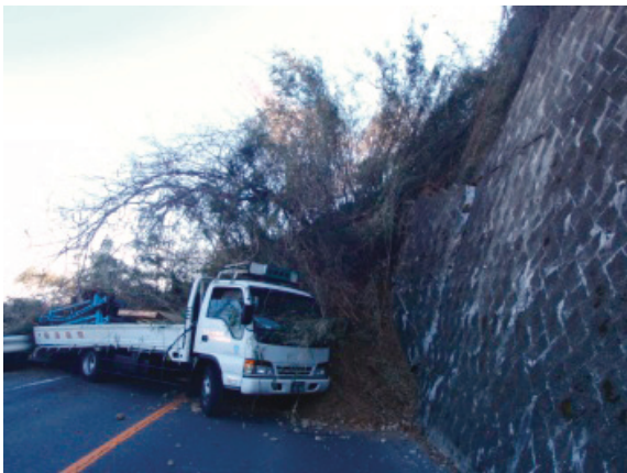
写真-2 国道408号の被災状況
