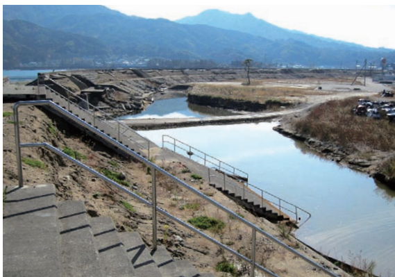
かねはま 金浜海岸（津波による海岸堤防の被災状況） (岩手県宮古市)
