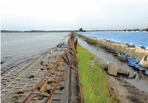
一級河川 ひぬま 湊沼川（地震動による堤防の沈下状況） （茨城県東茨城郡茨城町 いばらきまち ）
