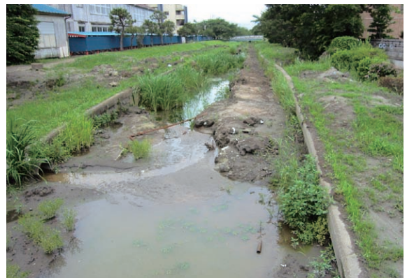
一級河川 じきゅうけん 十間川（液状化による周辺地盤の側方流動に伴う河床の隆起状況） （千葉県香取市）
