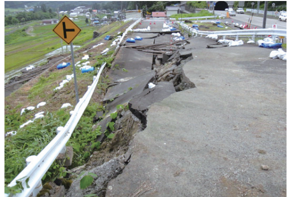
よこくらあおくら その他村道横倉青倉線（地震動による盛土道路の崩壊状況） (長野県栄村)
