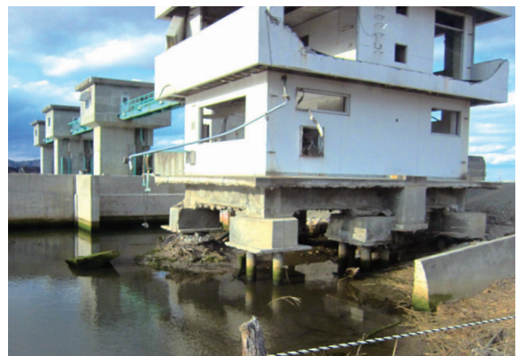
坂元水門（津波による水門の被災状況） (宮城県山元町)
