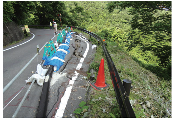
(主)白石国見線(地震動による谷側路面の被災状況) (福島県伊達郡国見町)
