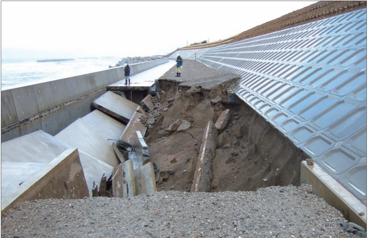
1月冬期風浪による被災(石川県小松市小松海岸):石川県撮影
