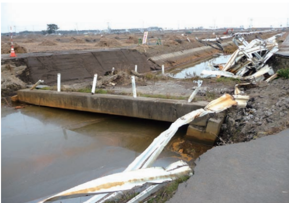
ごまいくだ きたぬまむかい 五枚下り北沼向線1号橋（津波による橋梁の全壊被災の状況） (仙台市若林区)
