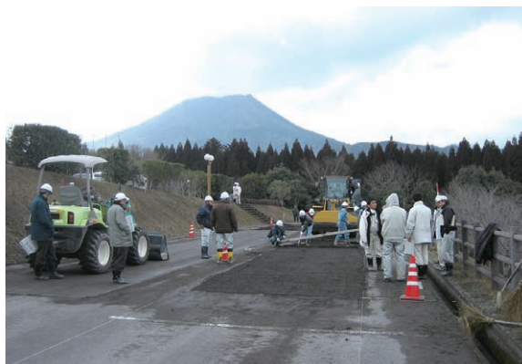
御池 みいけ 青少年自然の家駐車場（試験路面の作成状況） （宮崎県都城市）
