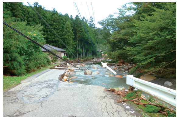
写真-3 鹿沼足尾線の被災状況
