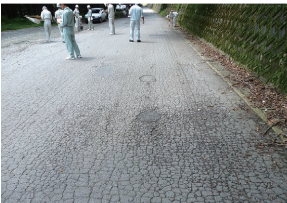
かなやまめいほう (主)金山明宝線 (凍上によるアスファルト舗装の損傷状況) (岐阜県郡上市)
