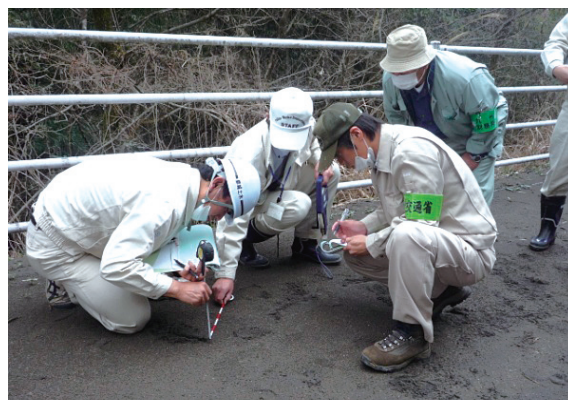
国道223号線（新燃岳の噴火に伴う査定の状況） （宮崎県都城市）
