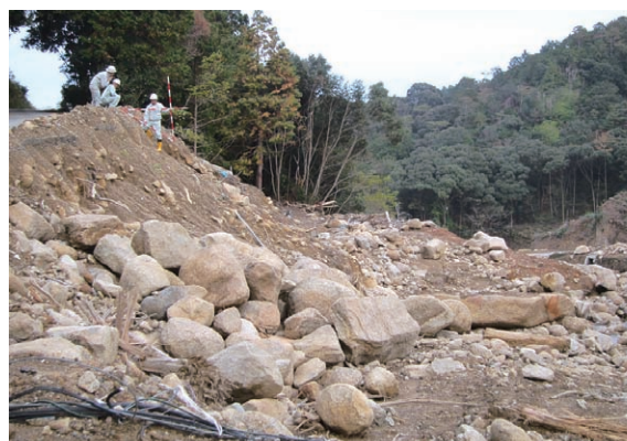
（主）那智勝浦古座川線（土砂流出による河川を横断する道路の損傷と埋塞の状況）（和歌山県那智勝浦郡）
