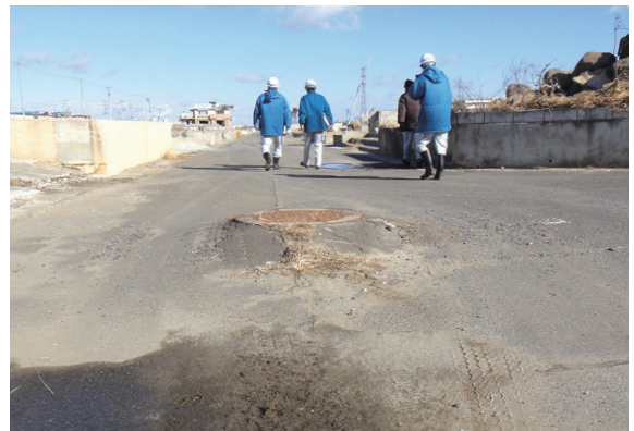
みなみがもう あらほま 南蒲生処理区荒浜地区 (地盤沈下による管路の被災状況) (宮城県仙台市)
