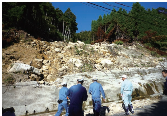
一般県道飛鳥日浦線（降雨による道路山側法面の崩落状況） （三重県熊野市）
