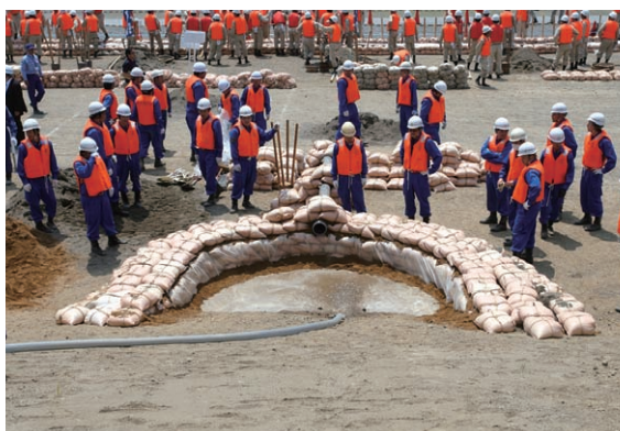
月の輪工 （中部：木曾三川連合水防演習・複合型災害防災実動訓練）
