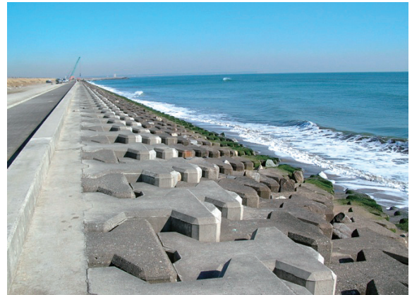
写真-4 被災前状況（匝瑳市野手）
