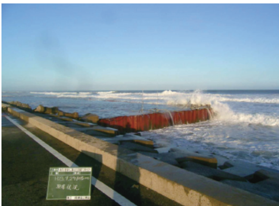
写真－10 排水能力不足により締切内の水位上昇 （匝瑳市野手）
