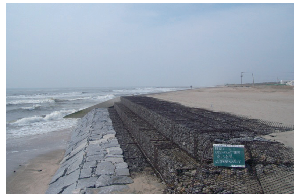
写真-11 被災した小口止めの復旧と再度災害防止のための護岸 (匝瑳市川辺)
