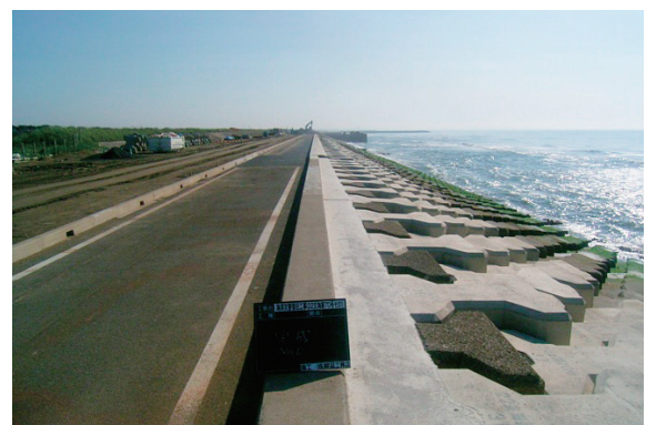
写真-12 復旧工事が3分の2完了 (匝瑳市野手)
