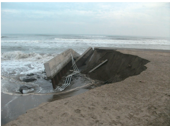
写真-3 緩傾斜護岸小口止めの転倒（匝瑳市川辺）
