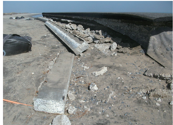
写真-7 護岸背後地の土砂が流出し、地盤高低下 (匝瑳市川辺)
