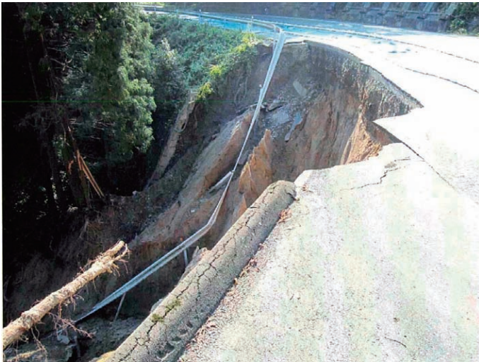
平成23年9月台風15号による災害：一般国道301号 (新城市豊栄地内)
