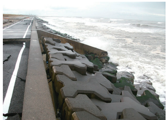
写真-5 緩傾斜護岸の崩壊（匝瑳市野手）
