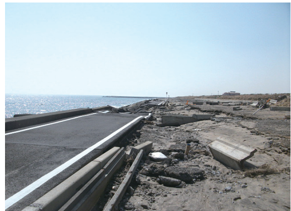
写真-8 護岸背後施設の散乱 (匝瑳市野手)
