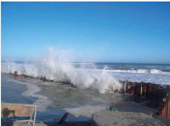
写真－9 越波状況（匝瑳市川辺）
