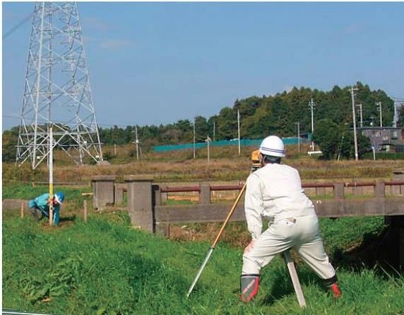
災害復旧工事の現場監督の様子（着工前の丁張検査）
