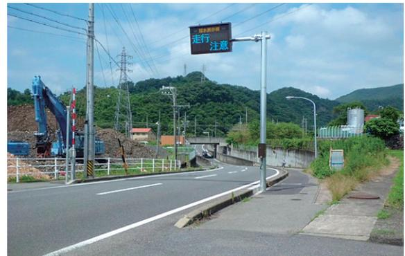
写真-17 道路情報提供装置の設置
