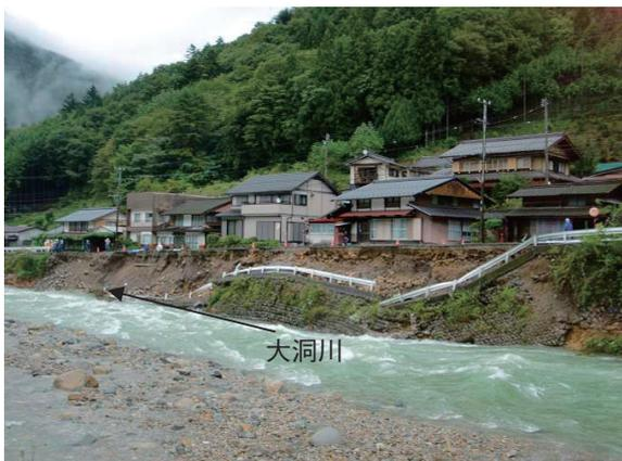
写真-9 路側兼用護岸の崩落
