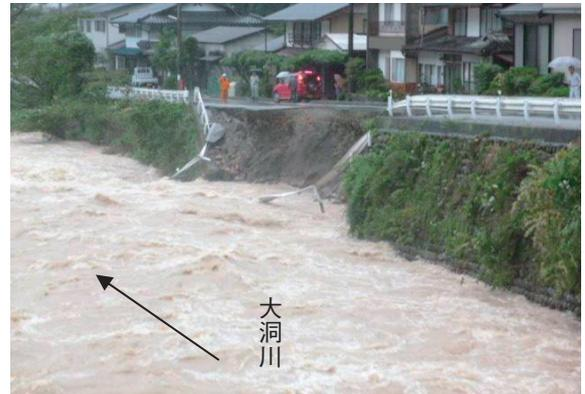
写真－7 路側兼用護岸の崩落
