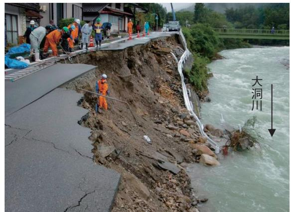
写真－8 路側兼用護岸の崩落
