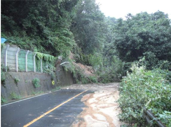
写真－5 台風第15号(主)名古屋多治見線(多治見市脇之島町地内)道路法面崩壊状況
