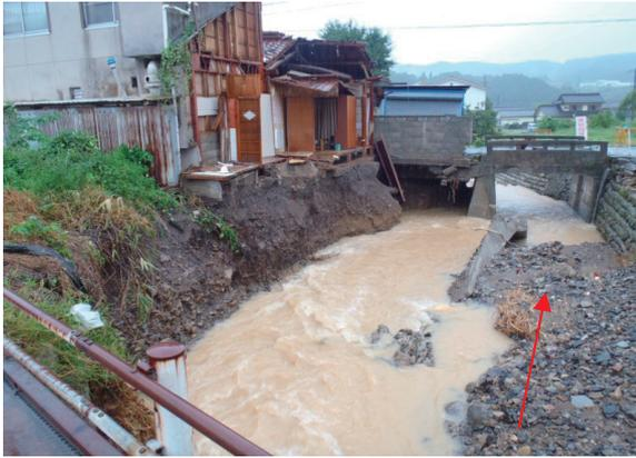
写真-10 護岸欠壊、家屋損壊
