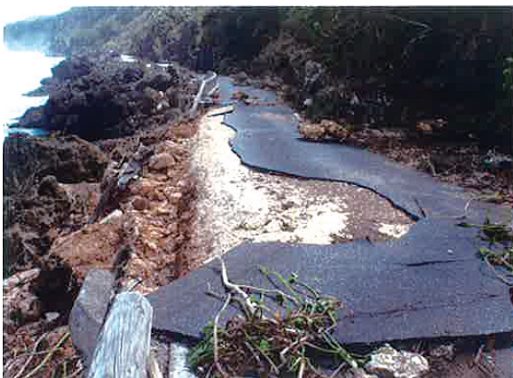
写真－7 台風17号被災箇所（事業者：伊江村） 路線名：湧出進入路 査定決定額：3,879千円
