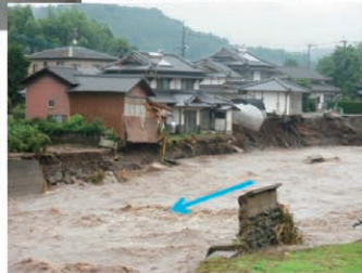
矢護川(護岸欠壊)熊本県
