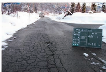
舗装面の亀甲状クラック及び盛上がり、沈下(山形県)
