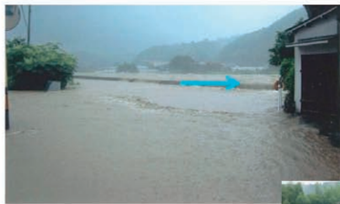
矢部川(浸水被害状況)福岡県
