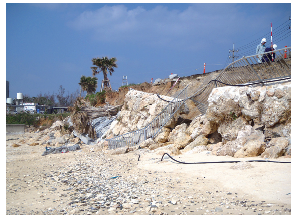
写真－9 台風15号被災箇所（事業者：沖縄県） 路線名：国道449号線 査定決定額：22,210千円
