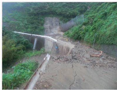
国道448号(路肩欠壊)宮崎県
