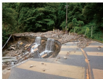
県道大津南郷宇治線(路肩欠壊)京都府
