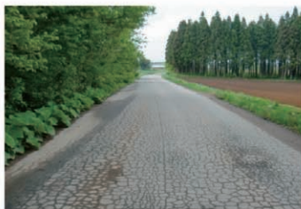
舗装面の亀甲状クラック及び盛上がり、沈下(青森県)
