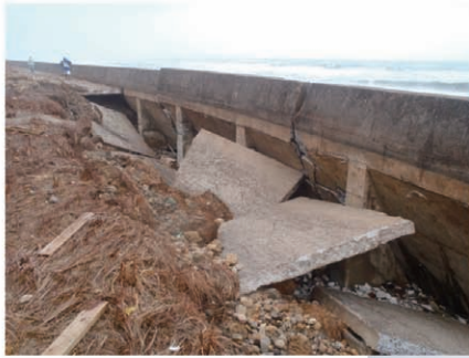
海岸被災状況(秋田県)
