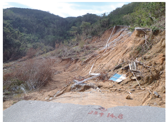
写真-5 台風15号被災箇所（事業者：国頭村） 路線名：辺野喜楚洲線 査定決定額：148,986千円
