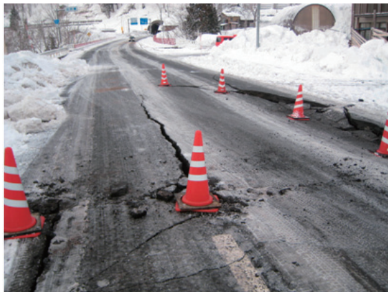
(国)117号 栄村の道路面の被災状況
