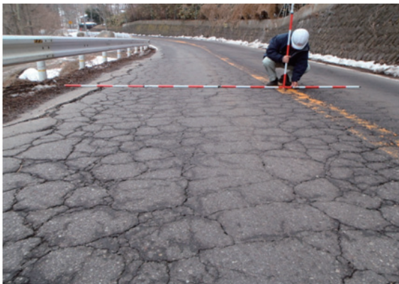
凍上災による被災状況
