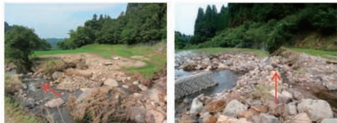
被害状況写真
