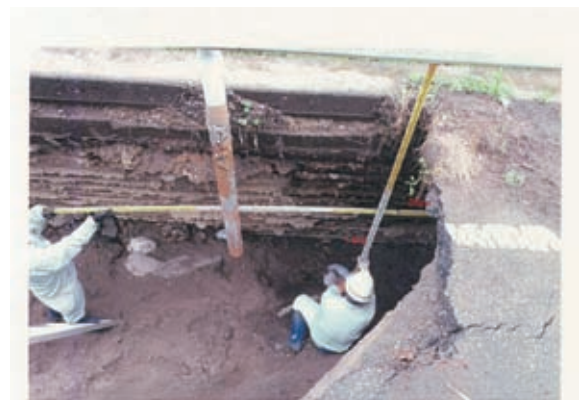
「死に体護岸」裏側での危険な調査
