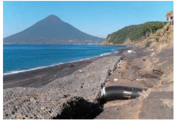
鹿児島県長崎鼻海岸（護岸被災）
