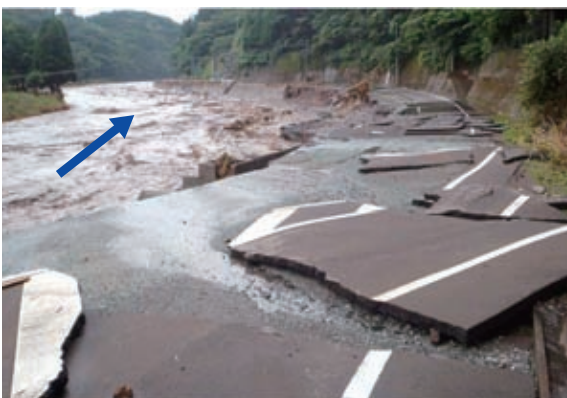
大分県国道502号（路肩崩壊）
