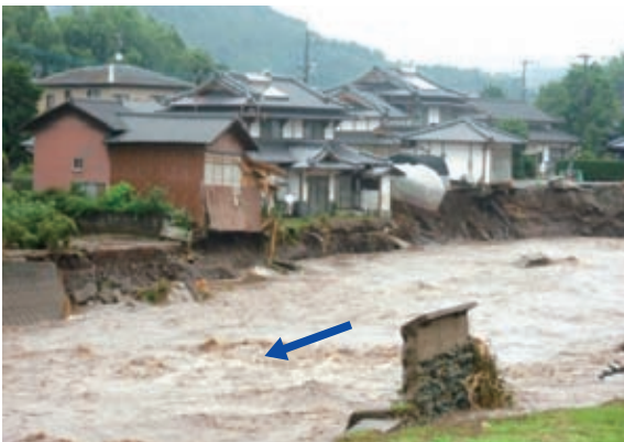
熊本県矢護川（護岸欠壊）
