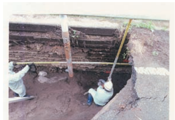
「死に体護岸」裏側での危険な調査
