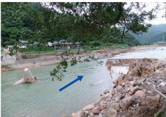
大分県山国川 柳ヶ平橋（橋梁災）
