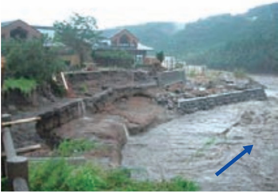
熊本県白川（大津町外牧地区護岸欠壊）
