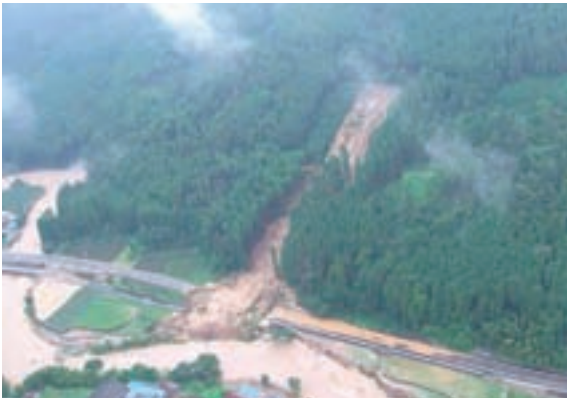
福岡県道 やめかわら 八女香春線（斜面崩壊）
