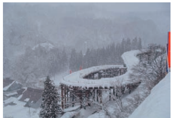
山形県大蔵村肘折地すべり災害
