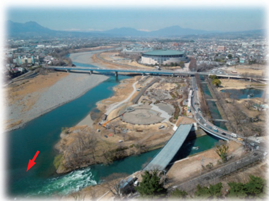
県庁20階からの眺望（利根川土木遺産群）
