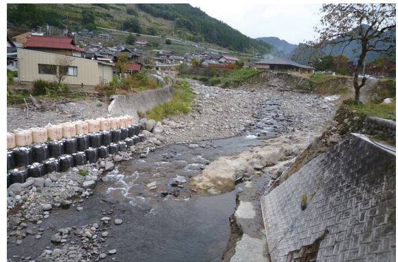
写真－7 福岡県八女市『朝霧：八女茶の里』の 龍川内川災害復旧関連事業箇所
