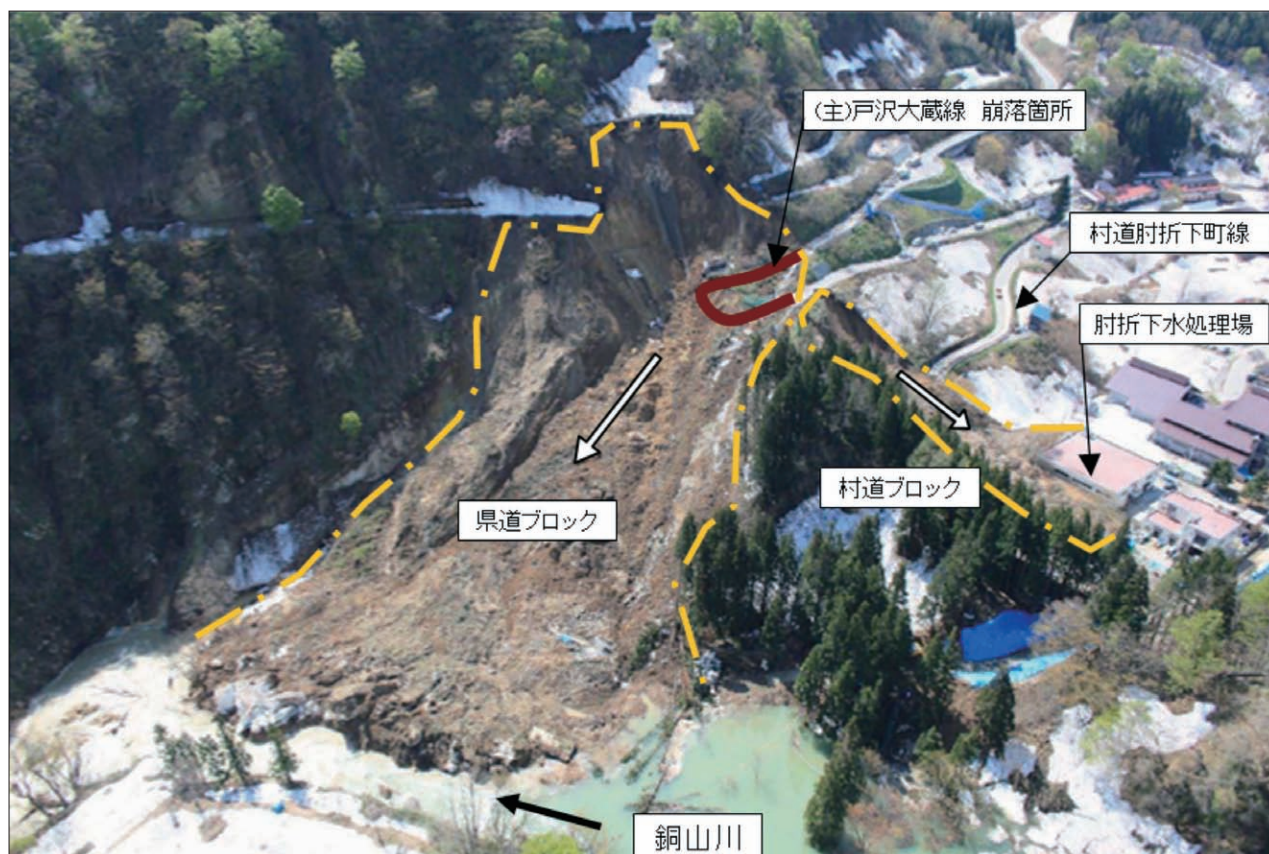
地すべり災害（平成24年3月～8月発生）主要地方道戸沢大蔵線 山形県大蔵村（写真提供：山形県）
