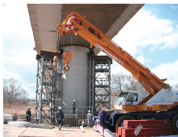
被災した支承(ローラー)の復旧工事施工状況
