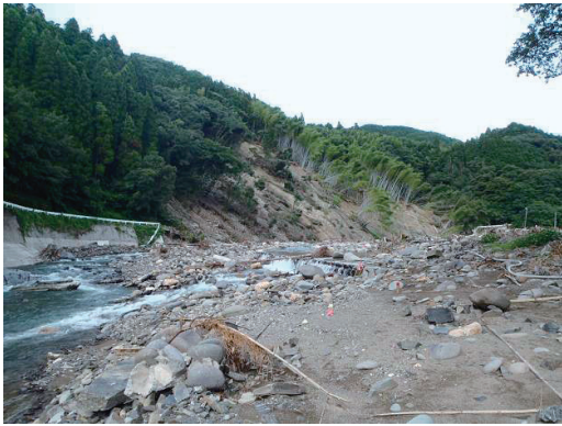
写真－3 洪水等による被害の状況 (星野川：八女市星野村)
