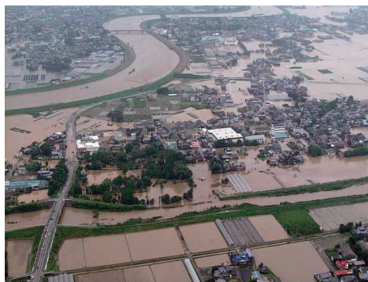
写真－1 洪水による被害の状況（沖端川：柳川市）
