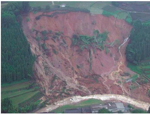
写真－4 山腹崩壊の状況 (笠原川：八女市黒木町笠原)
