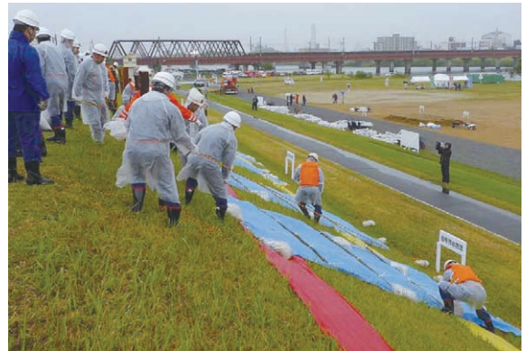
シート張り工 (大分川・大野川水防演習)
