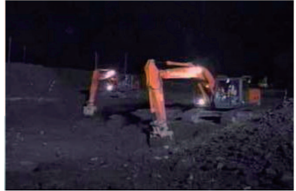
写真一12 国土交通省の照明車を借用し昼夜問わず、7台のバックホウで1万6千㎡を15時間で掘削を完了させた
