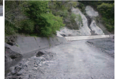
写真一 5 H23 河川災害工事を一時休止した矢先の崩落。白部分は仮設モルタル吹付・破線は護岸未施工部
