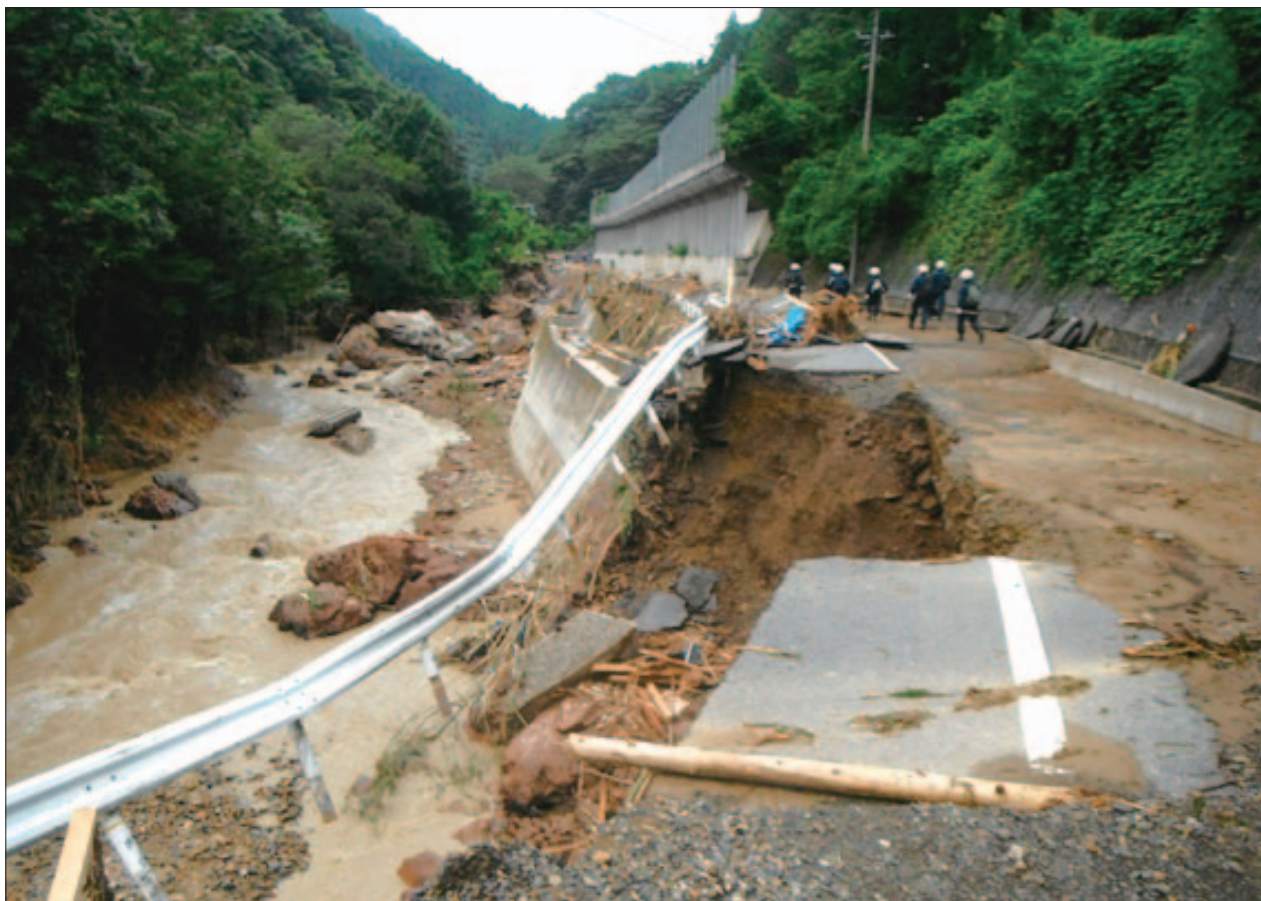
平成25年 7 月 28 日 山口・島根豪雨の被災状況 主要地方道萩津和野線 (島根県津和野町高峯)
