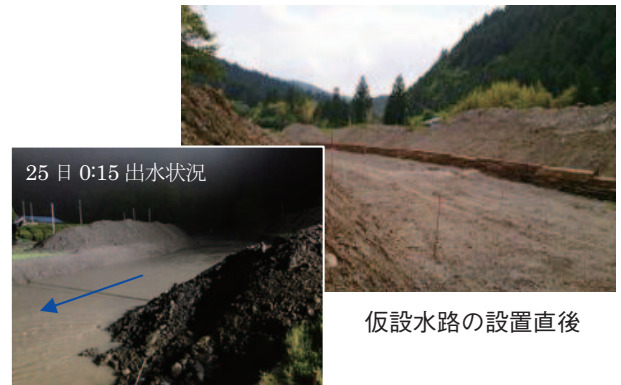
25日の通水状況
