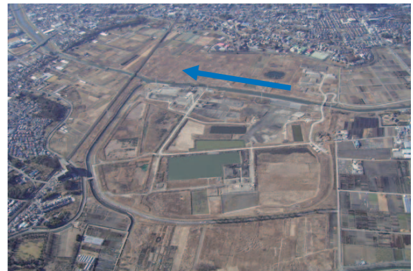
図-9 建設中の芝川第一調節池
