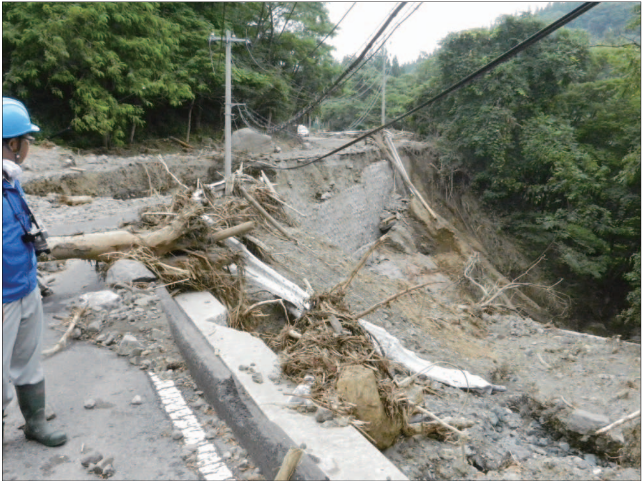
8 月 9 日からの東北地方を中心とする大雨による被災状況 岩手県紫波町山王海 町道 山王海 2 号線
