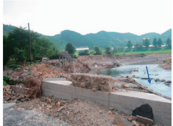
写真一7 二級河川阿武川（護岸崩壊）
