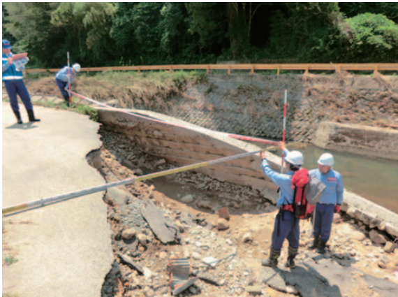
写真-16 TEC-FORCEによる現地調査
