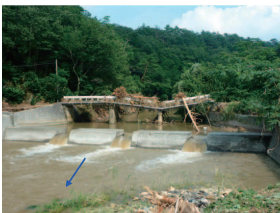
写真一12 市道小原線（上小原橋 橋脚沈下）
