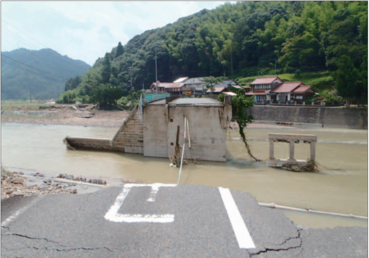
平成25年7月28日 豪雨災害の被災状況 主要県道益田阿武線 (道台兼用護岸崩壊)
