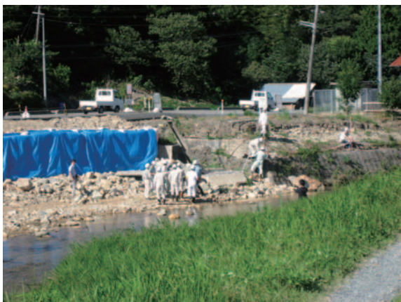
写真-18 山口県第3次査定（9/17～9/20） 災害査定の状況取材する報道機関
