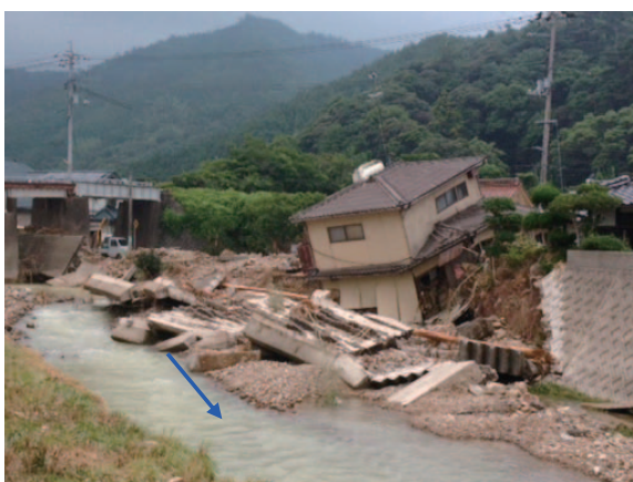
写真一11 二級河川須佐川（護岸崩壊）
