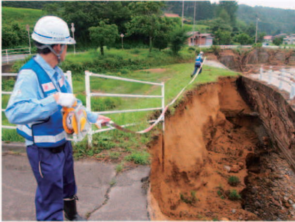
河川護岸の被災状況把握 (山口県萩市)
