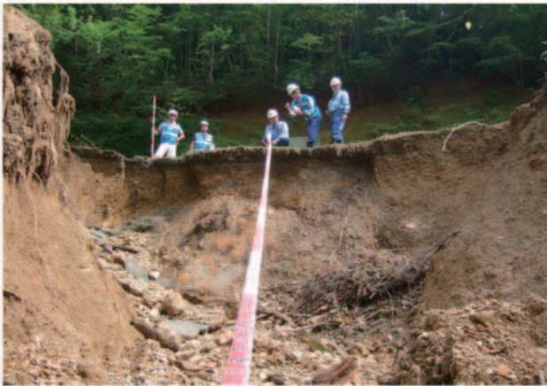
道路の被災状況把握 (滋賀県高島市)
