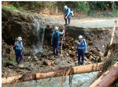
河川、道路の被災状況把握 (島根県津和野町)
