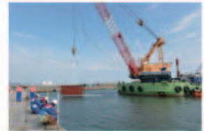
作業船による沈降障害物の揚収作業
