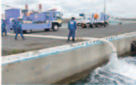
排水ポンプ車による津波浸水の排除
