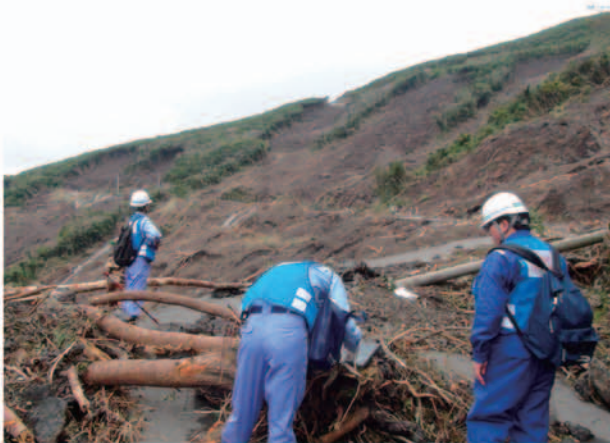
土砂災害の被災状況把握 (東京都大島町)
