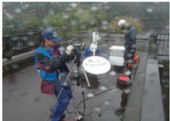
衛星通信設備、監視カメラの設置 (東京都大島町)
