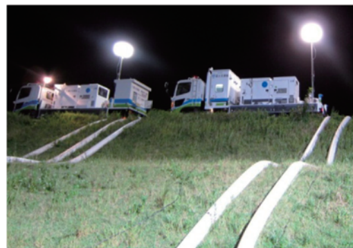
排水ポンプ車による緊急排水 (京都府福知山市)
