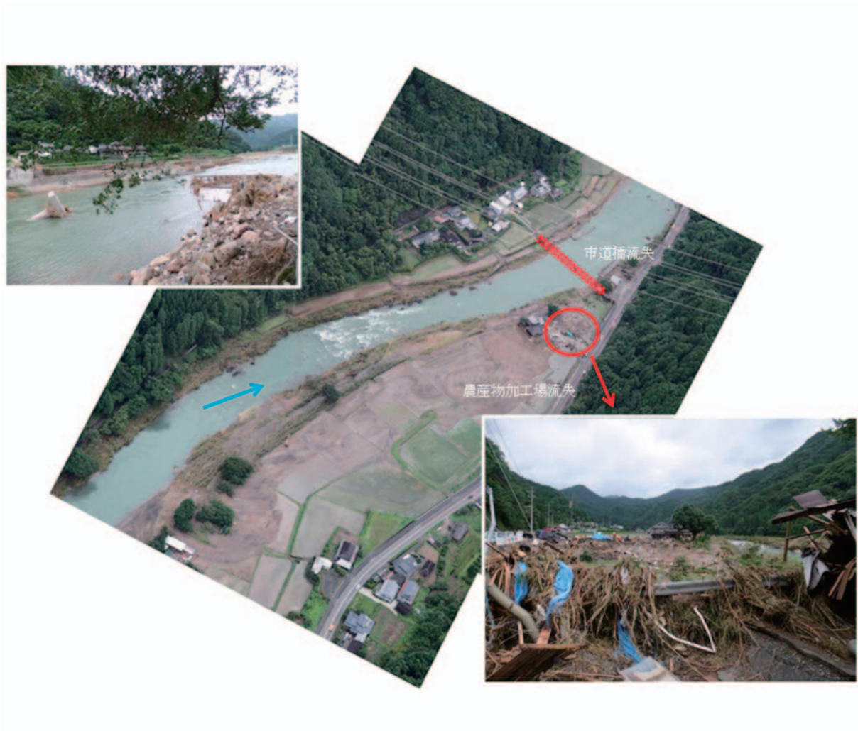
地域関連事業箇所〔山国川（柳ヶ平橋付近）被災写真（H24.7.5）〕
