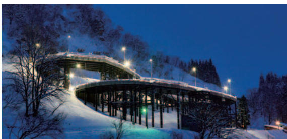
写真-8 雪の中の肘折希望大橋
