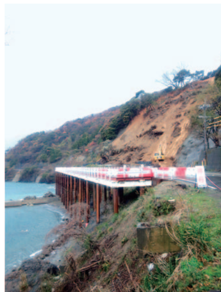
福井県 常神三方線 仮橋
