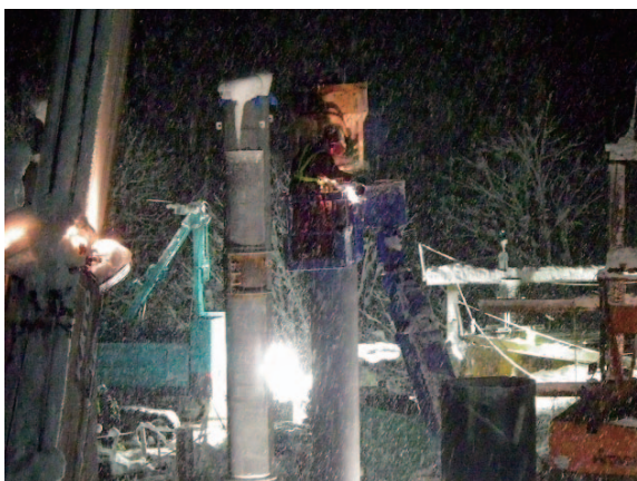
写真－2 大雪の中、夜を徹した工事
