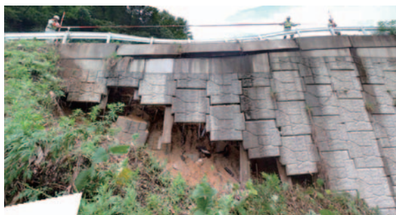
写真-13 補強土壁工の被災（白鷹町）
