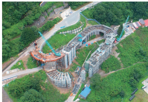
写真－5 上部工桁架設状況
