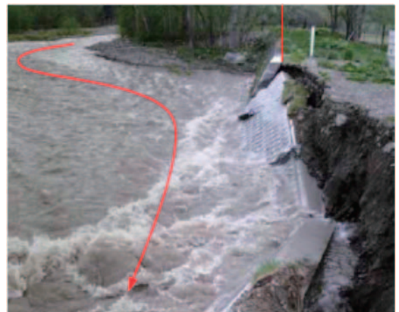
北海道 融雪災による護岸崩壊
