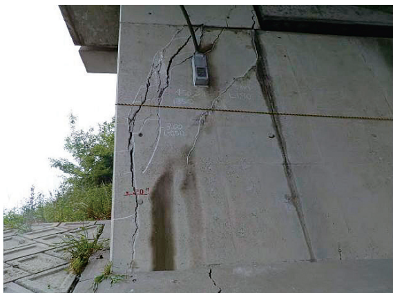
洲浜橋における橋台被災状況(兵庫県)
