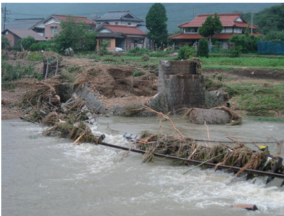
阿武川水系阿武川の JR 山口線橋梁流出状況（山口県）
