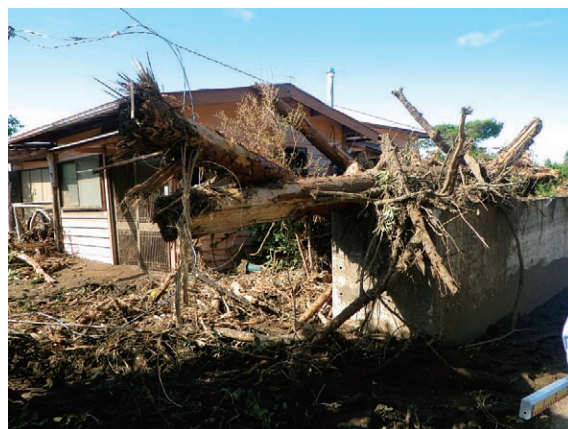
流木による家屋被害（東京都大島）
