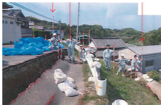
市道平田下道線における路肩欠壊状況(兵庫県)
