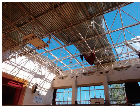
北陽中学校体育館における被災状況（埼玉県）
