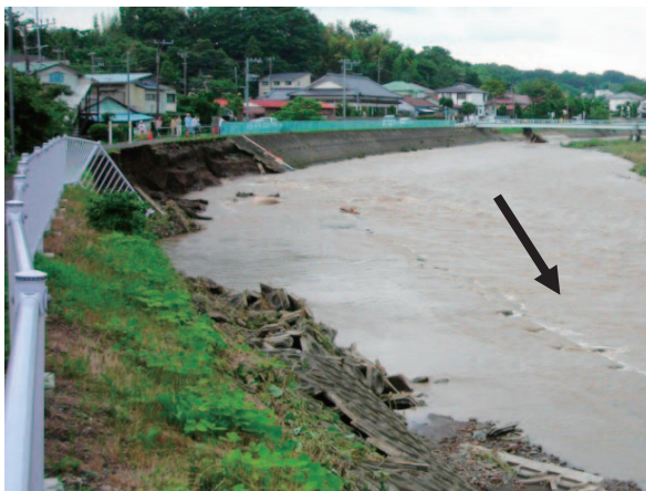
図－4 H24年災 第4号金目川被災箇所
