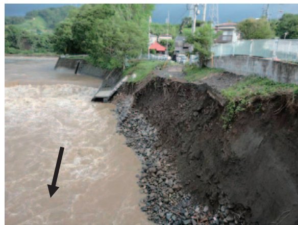
図-3 H24年災 第1号酒匂川被災箇所
