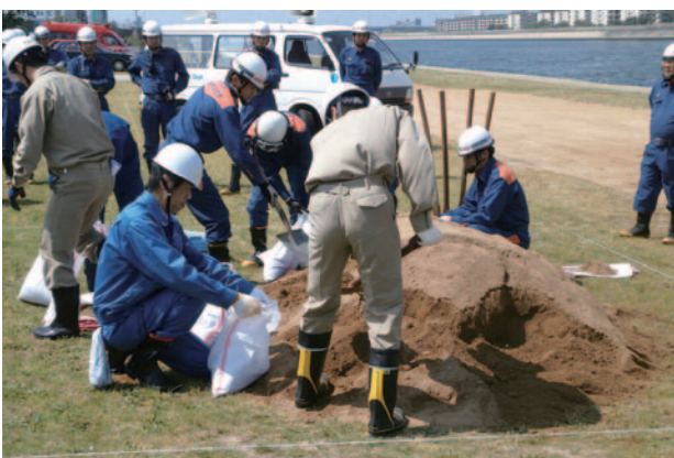
土のう作り・積み土のう工
