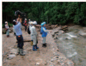
河川被災状況
