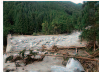
⑨砂防堰堤土砂埋そく状況
