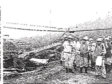
全国防災協会の災害復旧技術専門家による梨子沢の現地調査。24日、南木曾町読書。
