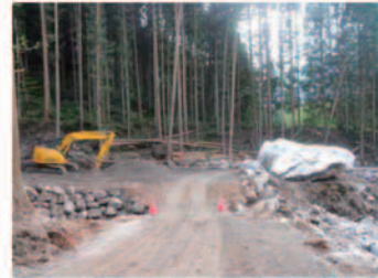
③仮道の状況
