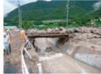
⑥県道橋被災状況
