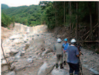
⑦砂防堰堤下流状況
