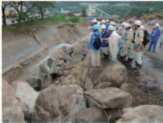
①護岸決壊状況
