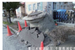
東日本被災状況(千葉県浦安市)
