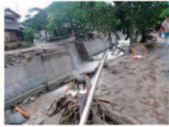
⑤町道橋被災状況2
