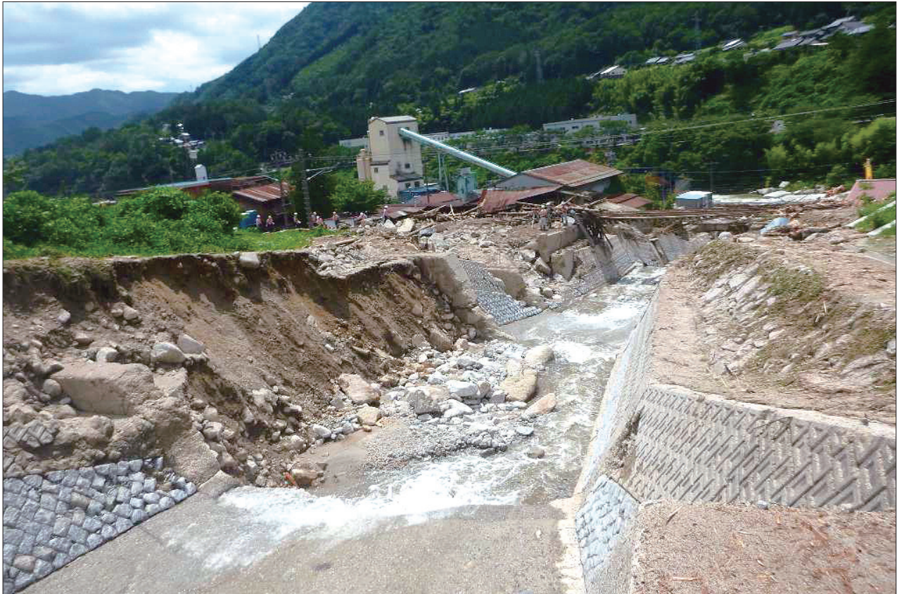
台風第 8 号及び梅雨前線豪雨による被災状況 準用河川梨子沢・長野県南木曾町 (写真提供：長野県)
