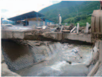
④町道橋被災状況1
