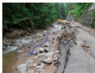
道路被災状況
