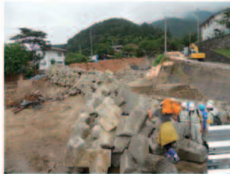
②応急工事状況
