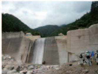
⑧砂防堰堤被災状況
