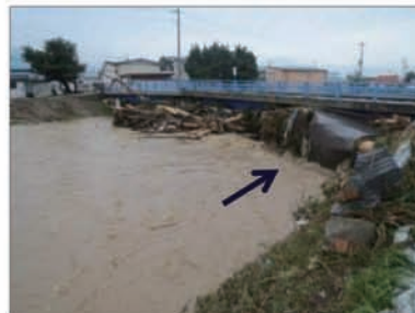
県道吉野橋 流木による河積阻害
