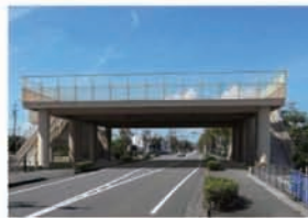
道路上の津波避難タワー (静岡県吉田町/H25年度完成)
