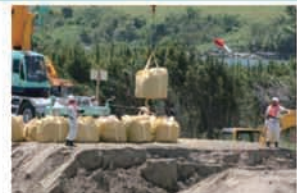
大型土嚢による堤防復旧訓練(四国)
