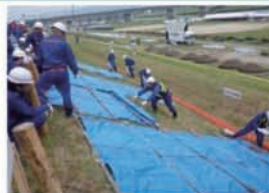
シート張工法による堤防保護(九州)
