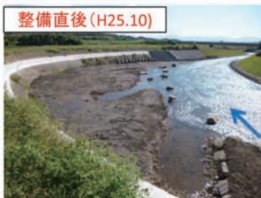
整備直後 (H25.10) 断面の余裕を活用しワンドを造成 水衝部には根固を配置
