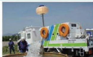
排水ポンプ車による緊急排水(近畿)
