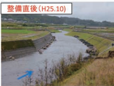
整備直後 (H25.10) 既設護岸保護のための根固め ブロックをどびとびに据え付け
