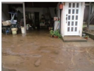
家屋浸水状況
