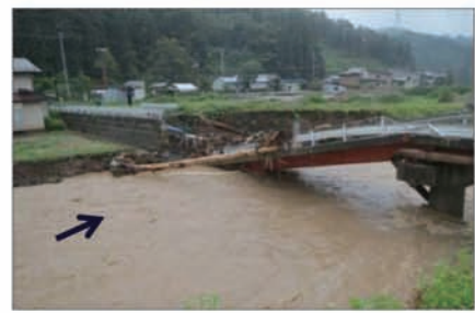
市道橋落橋状況
