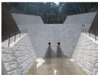
砂防堰堤の諸元 大町7号砂防堰堤 H=9.0m, L=32.0m
