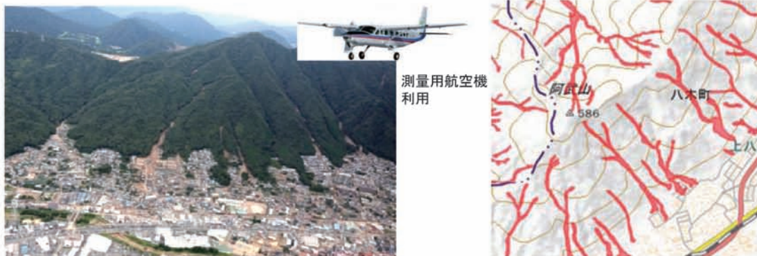
空中写真判読により電子地図に土砂流出箇所(赤)を重ね合わせた図を作成し、防災関係機関に速報
