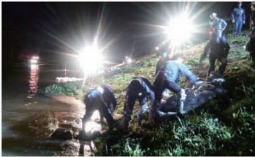
まち側の堤防法尻から漏水した箇所で水防活動を実施 (10月6日)
