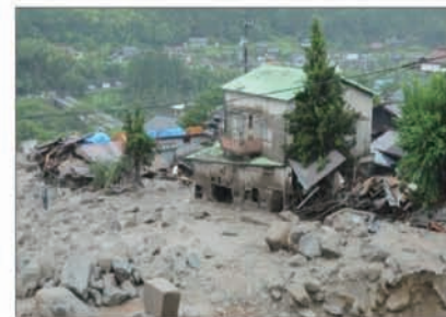
土石流による家屋の被災状況
