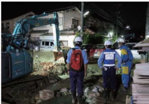
道路啓開の状況 (8月30日)
