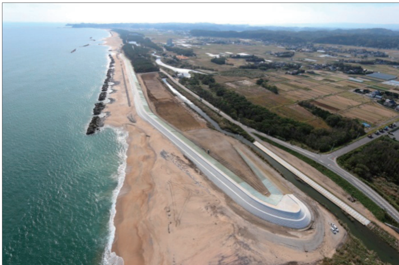
完成した福島県いわき市夏井地区海岸堤防
