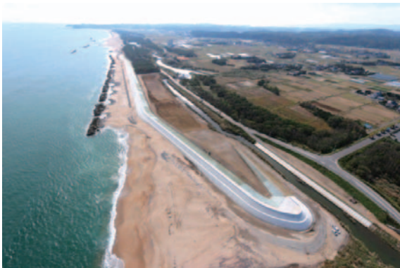
写真-6 完成した夏井地区海岸堤防
