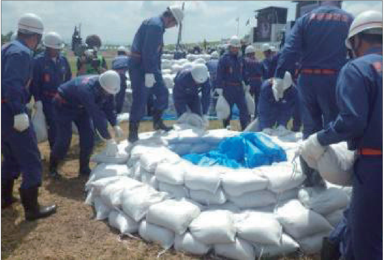
平成27年 6 月 20 日 平成27年度石狩川水系夕張川総合水防訓練 漏水対策工法 (釜段工) (北海道開発局札幌開発建設部 HP より)
