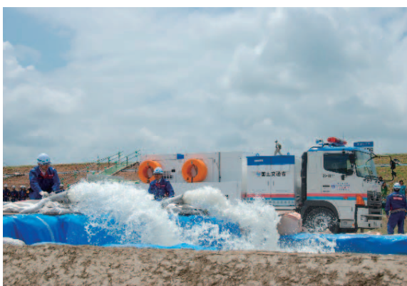
排水ポンプ車による緊急排水訓練 (石狩川水系夕張川総合水防演習)
