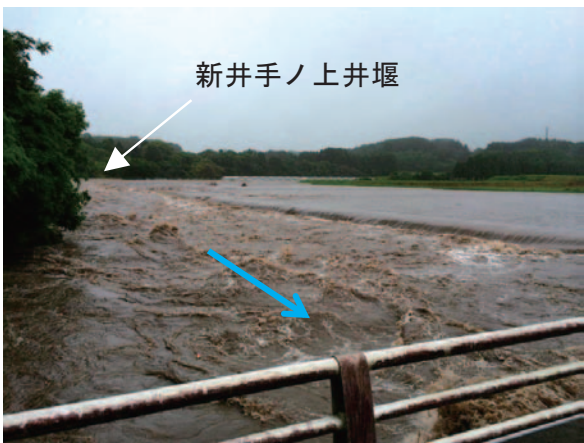
写真-4 上流側耕作地の浸水状況
