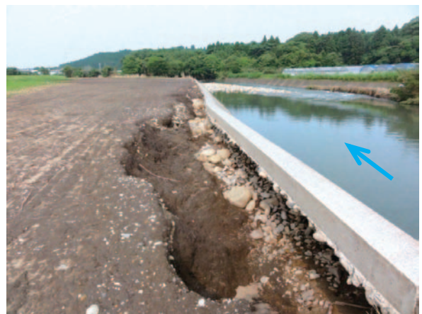
写真-6 護岸背面の浸食状況
