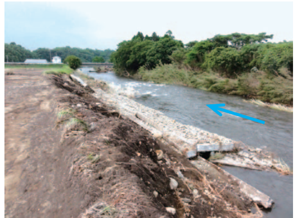
写真-5 護岸の倒壊状況
