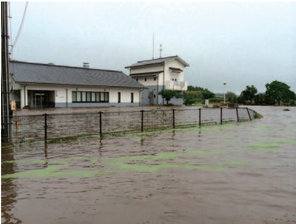
写真-3 川南浄化センターの浸水状況
