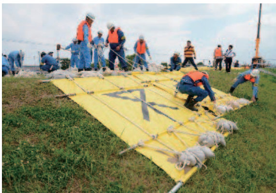
シート張工による堤防洗掘防止 (淀川水防・大阪府地域防災総合演習)
