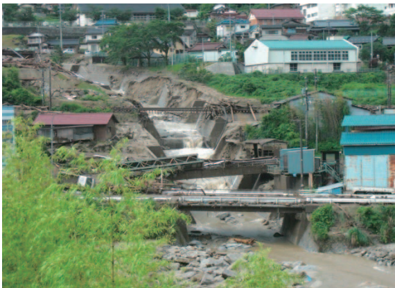
写真-3 梨子沢流路工の被災状況
