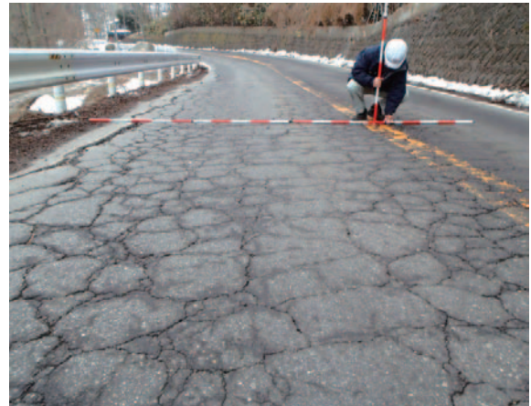
写真-1 凍上災害被災状況
