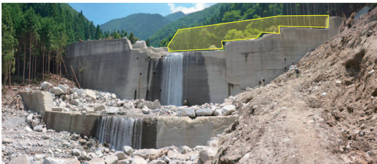
写真-4 梨子沢大型砂防えん堤の被災状況（ハッチングは吹き飛んだ袖部）
