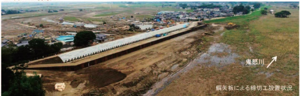
鋼矢板による締切工設置状況
