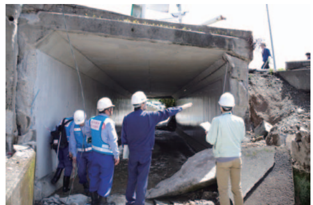
▲道路構造物の被災状況を調査（益城町）
