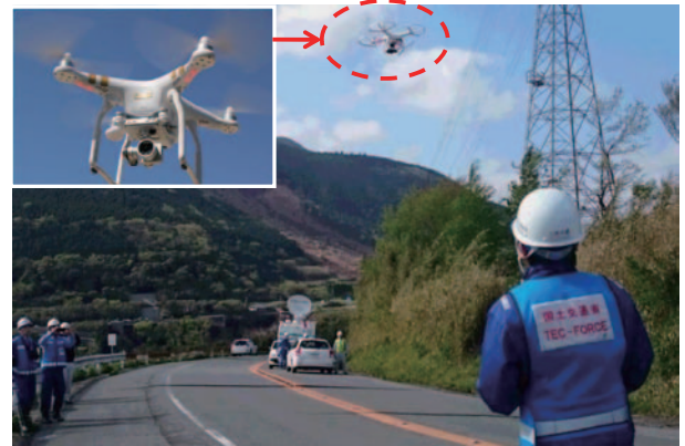
▲ドローンが離陸し崩落箇所へ急行
