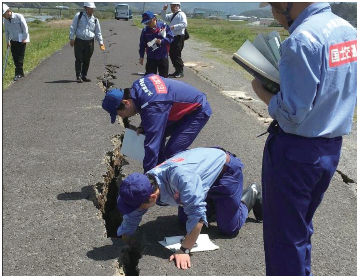
専門家 (TEC-DOCTOR・国総研・土研) による調査 (九州地方整備局 HP より)
