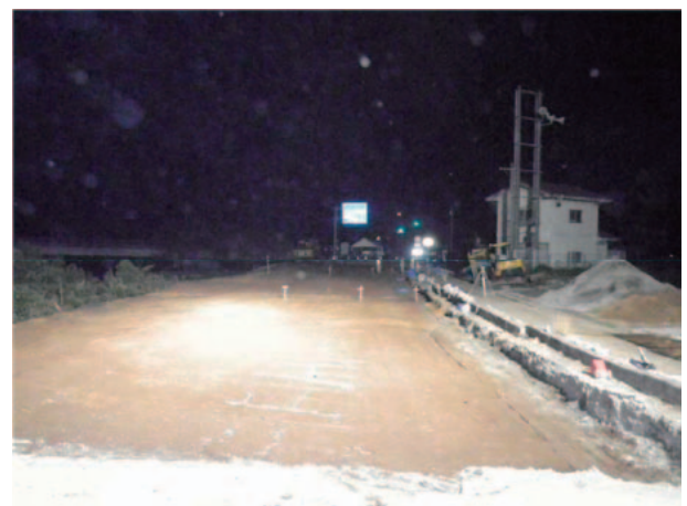
盛土完了（平成 28 年 4 月 21 日撮影）
