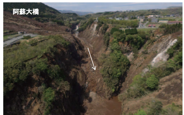
▲土砂崩落箇所を調査
