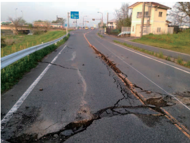
被災状況（平成 28 年 4 月 15 日撮影）
