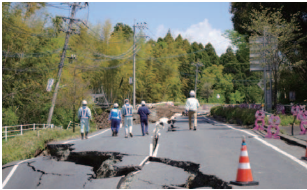
▲道路被災箇所を調査（益城町）
