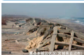
東日本被災状況(宮城県岩沼市)
