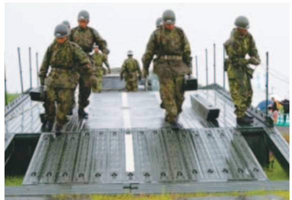
自衛隊による仮設橋設置訓練 (天塩川水系天塩川総合水防演習)
