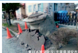
東日本被災状況(千葉県浦安市)
