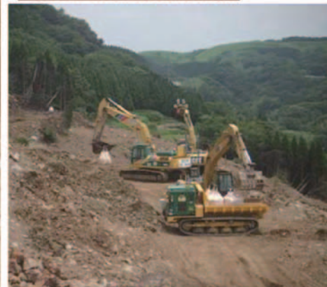
土留盛土工の造成(地盤改良)
