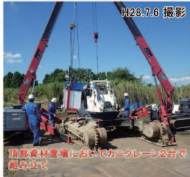
分解組立型バックホウ(1.0m 3 級)組立状況
