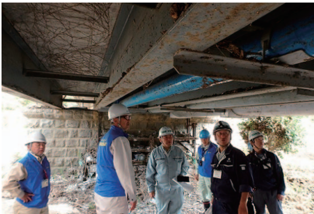
市道茂市橋線 (茂市橋)
