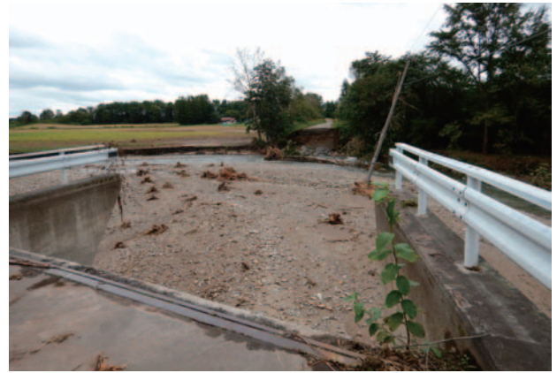
久三川河岸決壊による橋台背面崩壊
