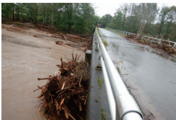
西芽室橋の橋脚傾き
