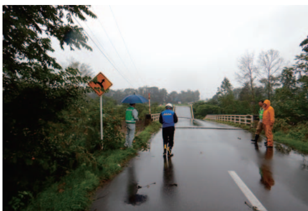
上芽室橋の確認状況
