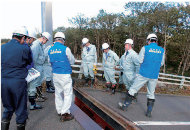
明星橋現地調査状況 2
