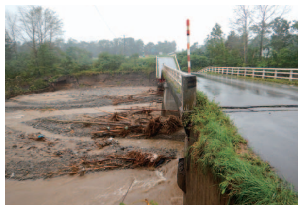
上芽室橋の橋脚傾き、上部工落下
