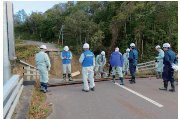
明星橋現地調査状況 1
