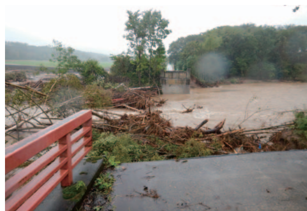
日新橋の橋脚傾き、上部工流出
