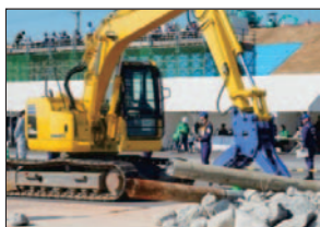
＜高知県建設業協会のバックホウによるがれき撤去＞
