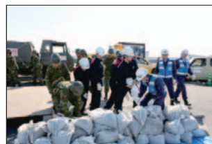
＜TEC-FORCE、陸上自衛隊、高知県、日本道路建設業協会の連携による路面段差解消（土嚢積み）＞
