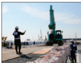
＜TEC-FORCE、日本建設業連合会連携による堤防応急復旧＞
