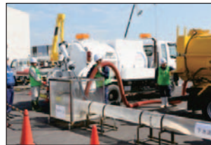
＜高知市上下水道局、日本下水道管路管理業協会による下水管復旧＞
