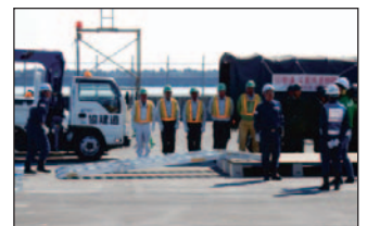
＜西日本高速道路の路面段差解消（アルミブリッジ）＞
