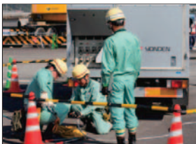
＜四国電力による配電線応急復旧＞
