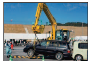
＜高知県建設業協会のバックホウによる車両移動＞
