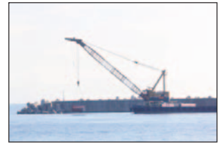
＜日本埋立浚渫協会、日本海上起重技術協会の起重機船による航路啓開（航行障害物の除去）＞
