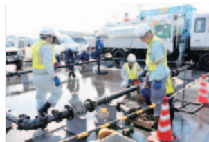
＜高知市上下水道局、高知市管工事設備業協同組合による水道管復旧＞
