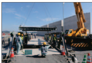
＜TEC-FORCEによる応急組立橋設置＞
