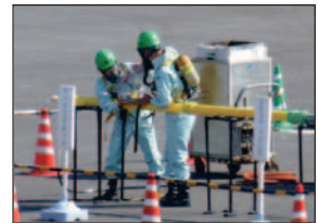
＜四国ガスによる都市ガス応急復旧＞
