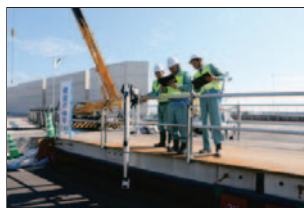
＜TEC-FORCEによるPC建設業協会の連携によるPC橋梁の点検＞
