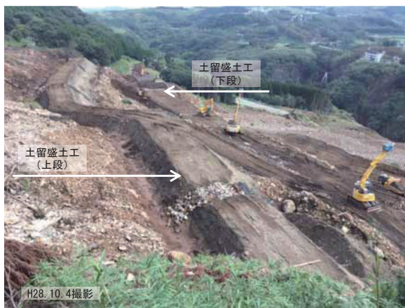
土留盛土工の造成(熊本側より望む)
