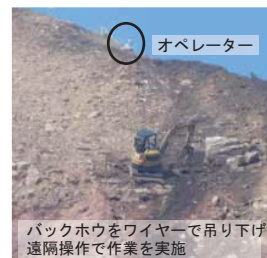
頂部のラウンディング状況(高所法面掘削機での施工)
