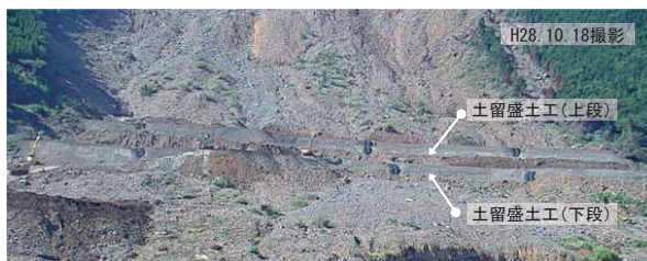
土留盛土工の全景(対岸より望む)
