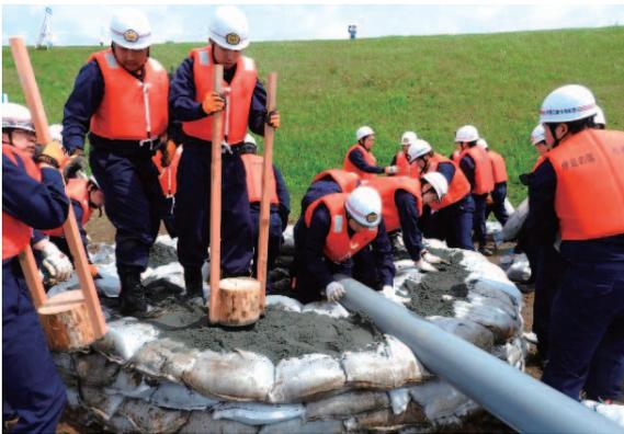
漏水防止工法（釜段工）
