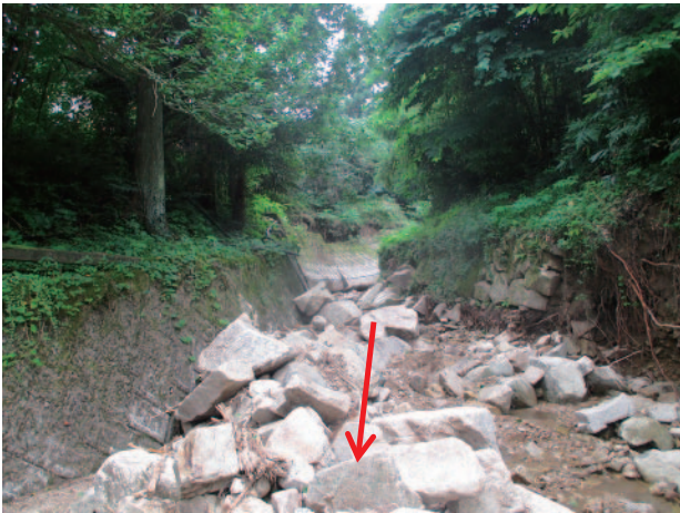
河床洗堀による護岸被災
