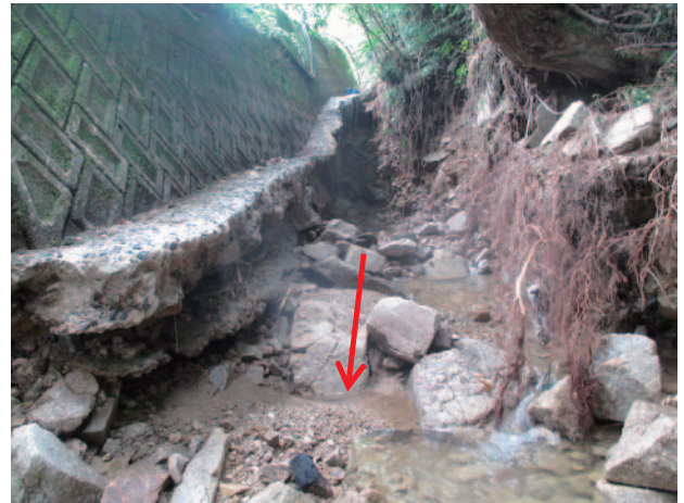
河床洗堀による護岸被災
