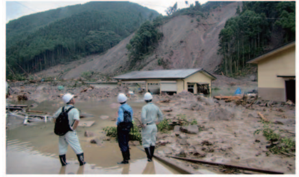
【日田市小野地区】 斜面崩壊状況
