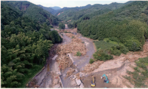
【朝倉市山田地区】 流木堆積状況
