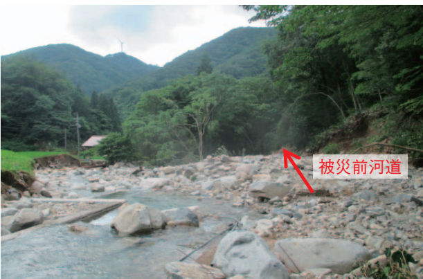
河道埋そくによる氾濫
