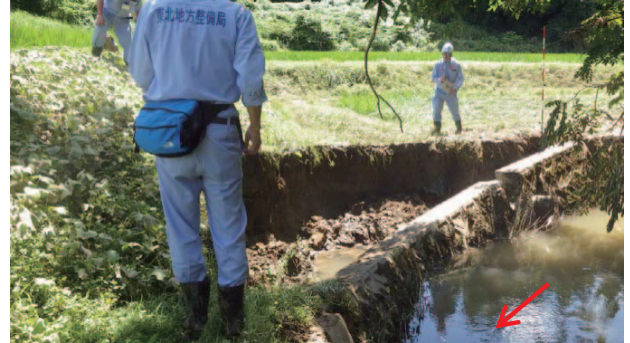
【大仙市】古種沢川（河岸被災状況）
