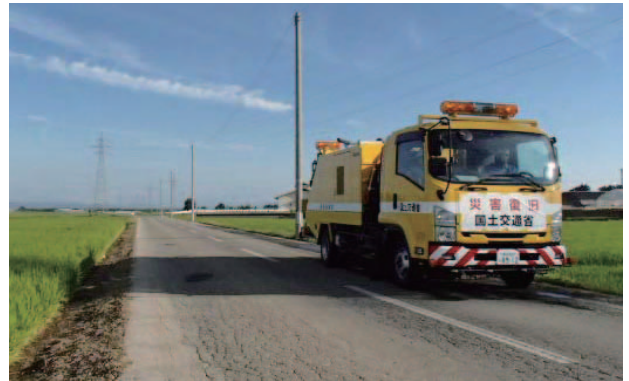
撤去作業完了
