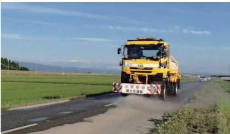
散水車による泥の洗い流し作業①
