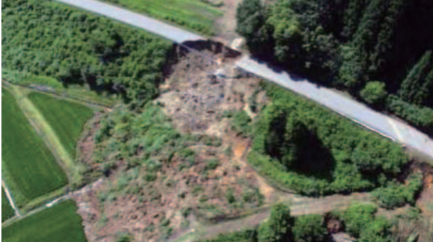
【横手市】二井山上溝線（土砂崩落状況）
