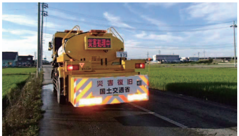
散水車による泥の洗い流し作業②
