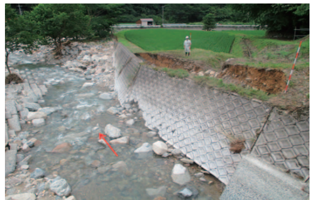
河床洗掘による護岸、根固め被災
