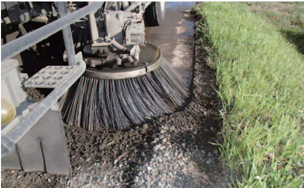
路肩用ブラシによる堆積土砂の撤去作業
