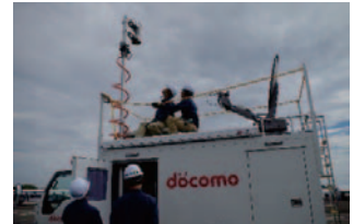
<携帯端末エリアの応急復旧のためNTTドコモによる移動基地局の設置>
