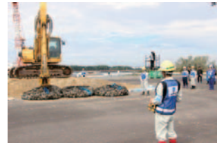
<遠隔操作による堤防復旧>
