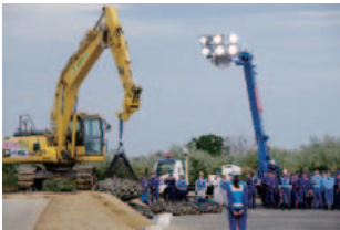
<TEC-FORCE、日本建設業連合による堤防応急復旧>
