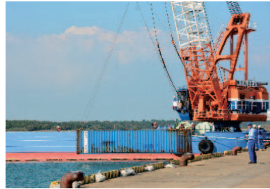
<災害協定団体の起重機船による航路啓開訓練>
