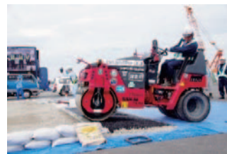
<日本道路建設業協会、NEXCO西日本、TEC-FORCEによる段差解消>
