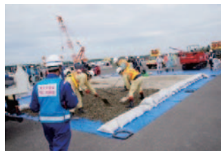
<日本道路建設業協会、NEXCO西日本、TEC-FORCEによる段差解消>
