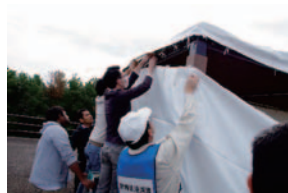
<避難施設の東屋のベンチを囲い 災害時トイレを設営中>
