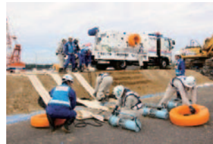
<TEC-FORCEによる排水ポンプ車を使用した排水活動>
