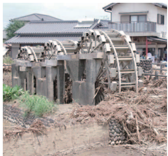
写真－2 被災した国史跡三連水車（福岡県朝倉市）
