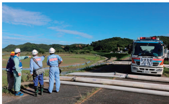
排水状況の確認
