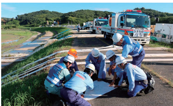
作業工程打合せ
