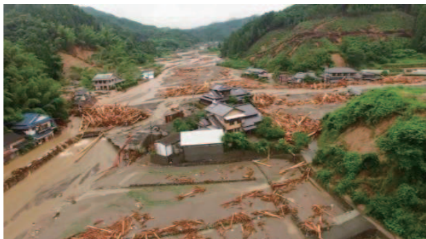
赤谷川の土砂・流木被害（福岡県）
