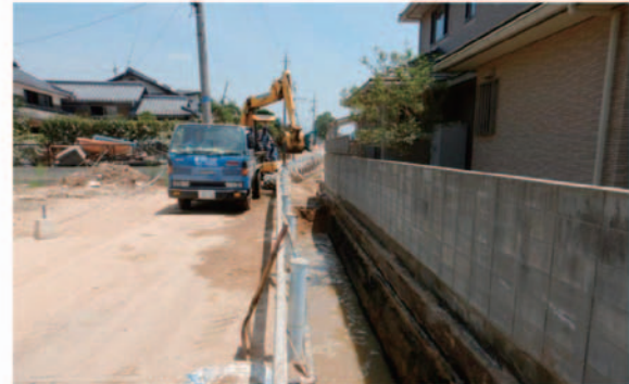
水路啓開作業 (倉敷市真備町)
