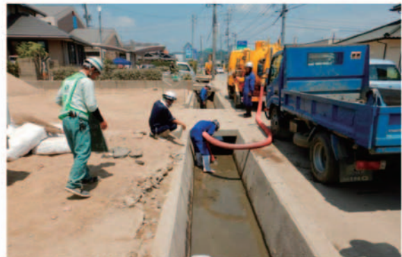
水路啓開作業 (倉敷市真備町)
