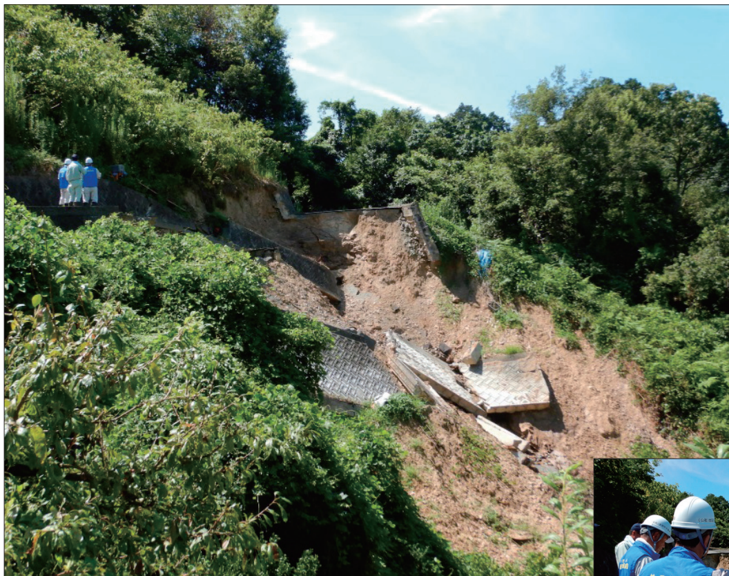
技術専門家・現地調査 H30.8.8 愛媛県宇和島市吉田町 白浦地区 市道三ツ尾越センバ線
