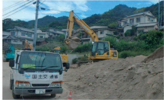
現地状況確認 (坂町坂西)
