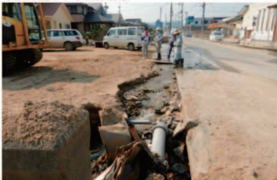
水路啓開作業打合せ (倉敷市真備町)
