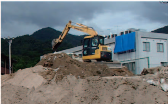
道路啓開作業 (坂町小屋浦)
