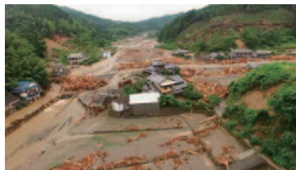
土砂・流木による被害 (筑後川水系赤谷川)
