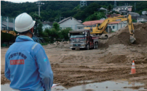
現地状況確認 (坂町坂西)
