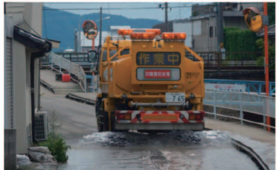
散水作業 (坂町小屋浦)
