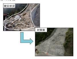
災害復旧事業の対象とならない風化による崖崩 れで通行止めが発生したため、災害対策推進費に より法面対策を実施しました。
