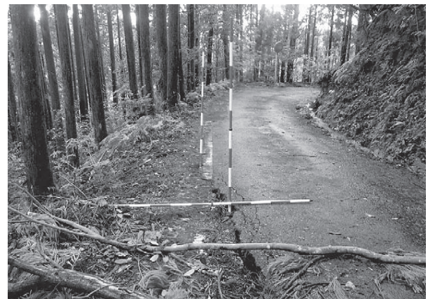
写真-2 樹木の状況（被災箇所の前後）
