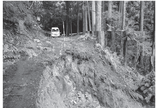
写真-1 崩落の状況（被災箇所）
