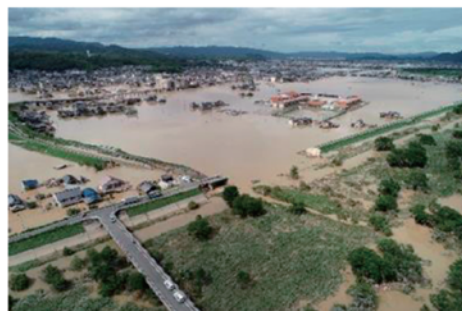
堤防決壊状況（高梁川水系小田川）
