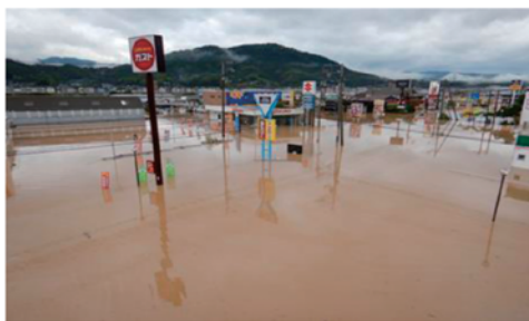
東大洲地区の浸水状況（愛媛県大洲市）
