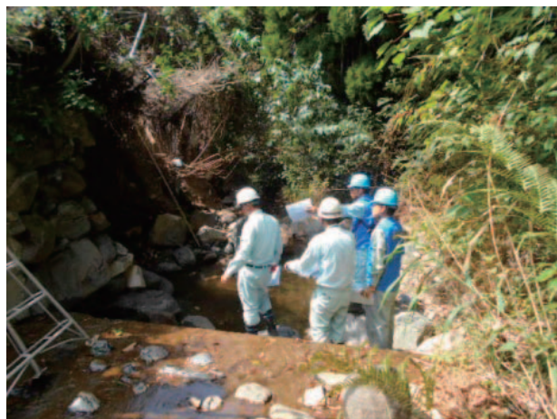
申川内川護岸被災状況
