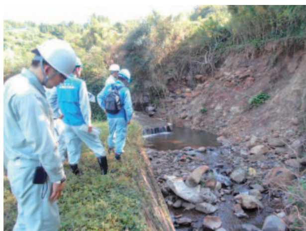
岩屋川内川護岸被災状況
