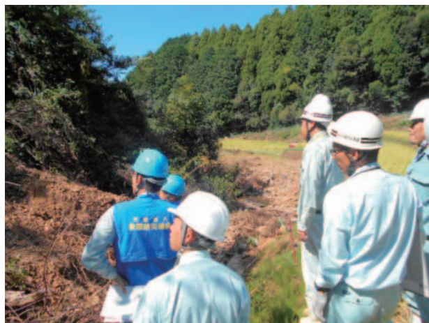
岩屋川内川河道閉塞状況
