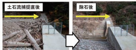
砂防堰堤の除石事例
