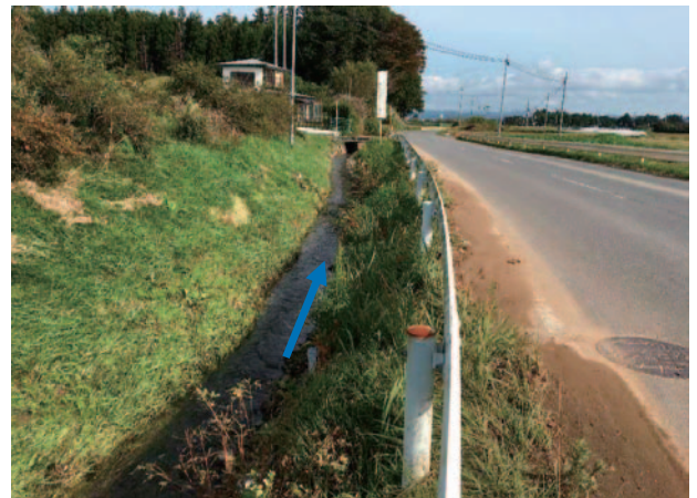
②不動沢川 県道のBOX下流側 河道法欠け状況 護岸申請は可能
