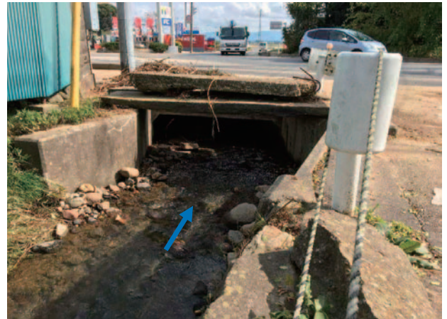
②不動沢川 県道の下BOX 河道埋そく状況（6割）
