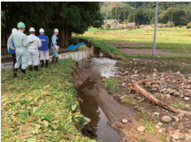
①大平川 越流により堤防流失 護岸からの漏水あり 水田に土砂堆積
