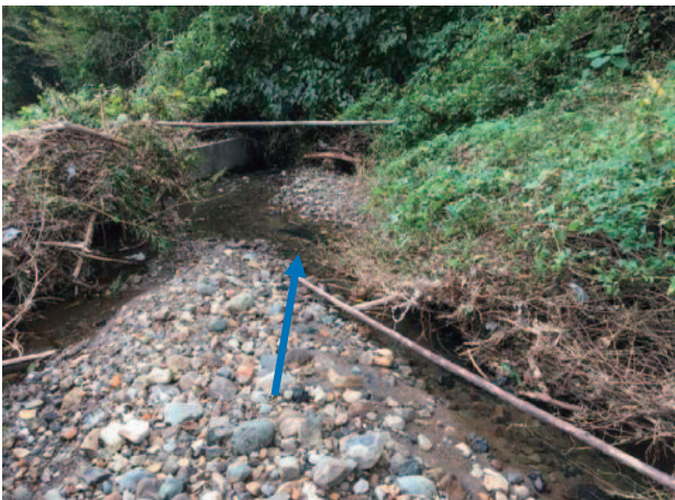
④桜清水川 河道には土砂堆積
