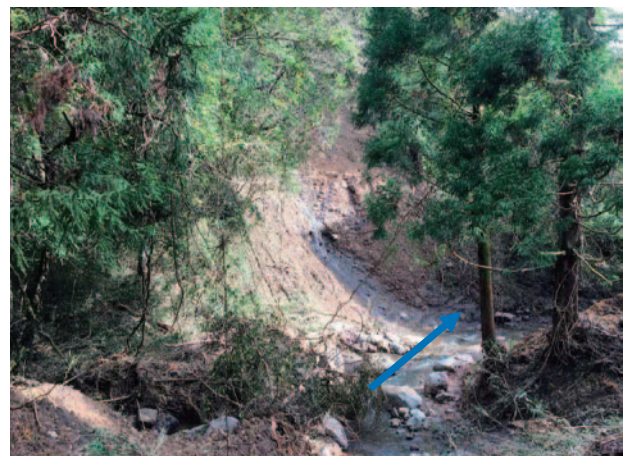
③-2 平沢線 石生川左岸の森林法面の状況
