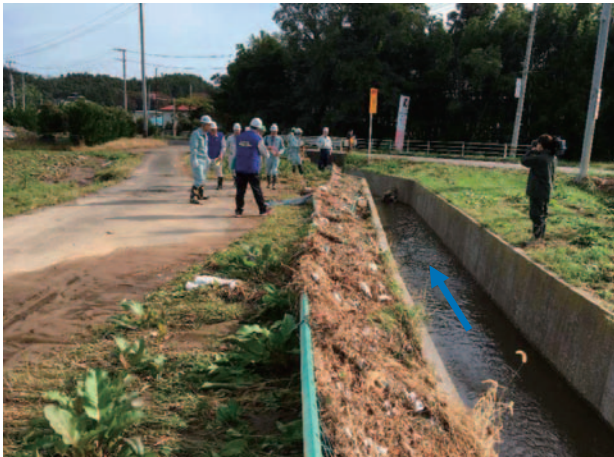
①大平川 越流により転落防止柵の倒壊
