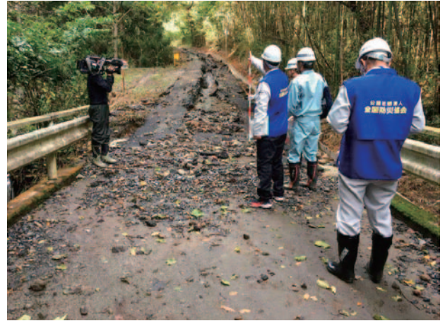
③-1 平沢線 石生川に架かる橋の上流の道路
