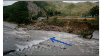
【千曲川：護岸崩壊】 長野県 小海町 千代里 地先～東馬流 地先
