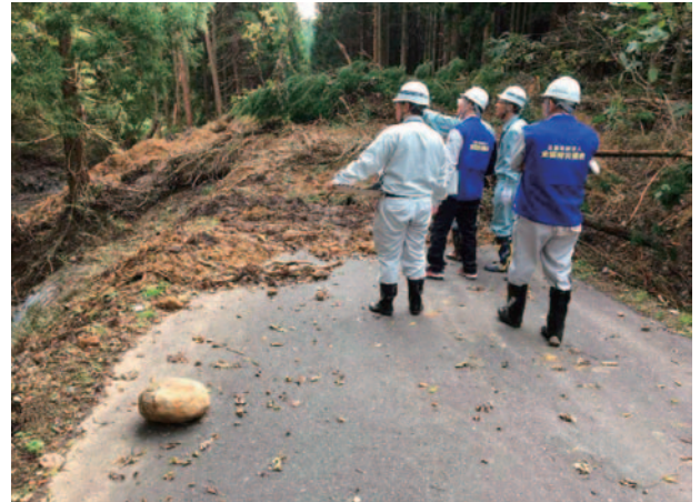
③-2 平沢線 対岸の表面地すべりにより土砂堆積
