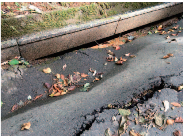
③-2 平沢線 路面を流れたため路盤流失 陥没により側溝の基礎も流失
