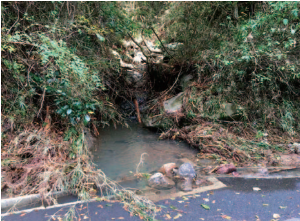
③-1 平沢線 被災の上流に横断暗渠 呑口樹が土砂で閉塞
