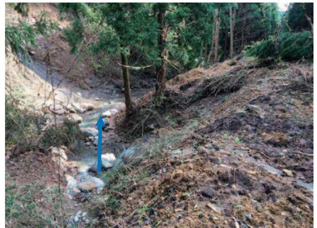
③-2 平沢線 石生川に堆積した土砂は下流へ流れた状態
