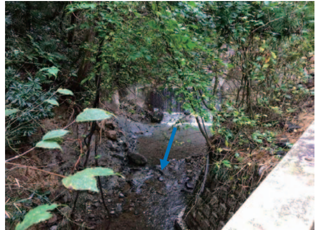
③-1 平沢線 石生川 橋の上流の治山ダム
