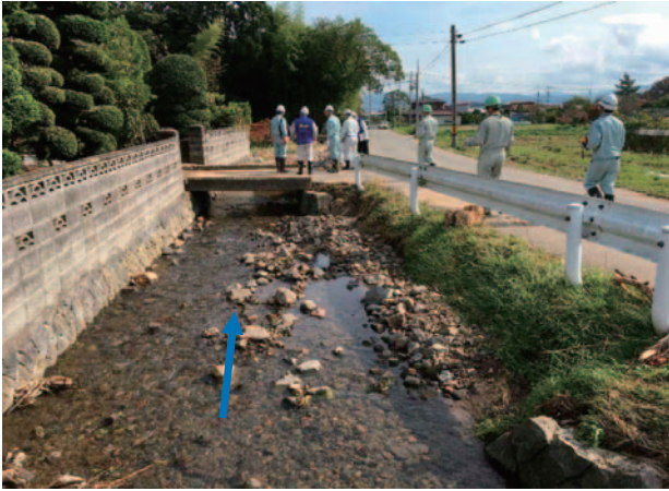
②不動沢川 県道の BOX 上流側 河道埋そく状況
