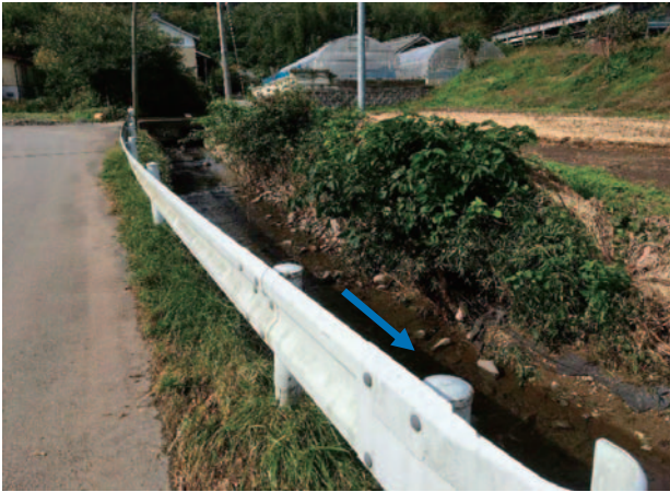
②不動沢川 県道の BOX 上流側 河道法欠け状況 天然河岸から護岸申請は可能
