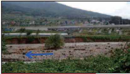
【夜間瀬川：護岸崩壊】 長野県 中野市 笠原 地先
