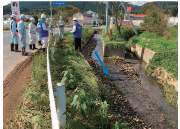
②不動沢川 県道のBOX下流側 河道埋そく状況
