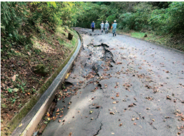
③-2 平沢線 路面を流れたため路盤流失
