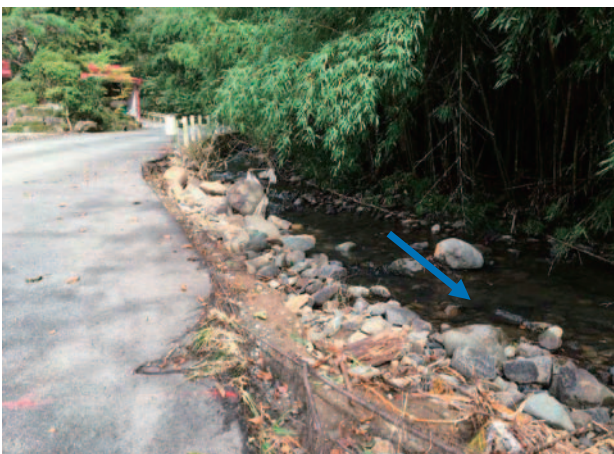
④桜清水川 上流側の法面流失 ブロック積みでの復旧は可能
