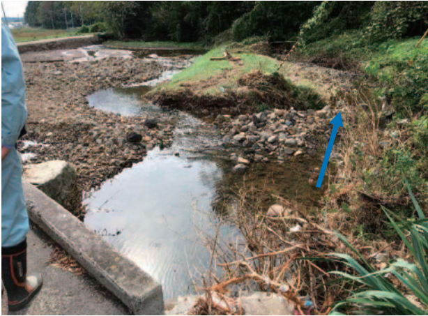
④桜清水川 河川堤防決壊 河道には土砂堆積 水田には土砂流入
