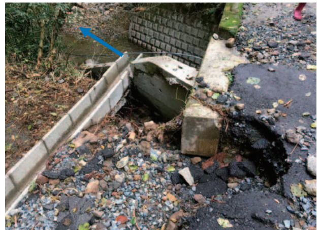
③-1 平沢線 石生川に架かる橋の護岸 背後は洗掘
