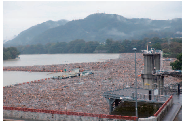
城山ダム、大量の流木が堆積
