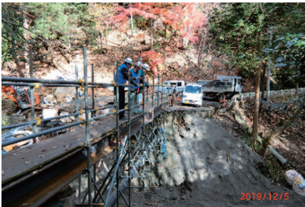
厚木土木管内： 土石流により BOX カルバート流出、仮橋架橋
