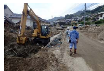
河道閉塞箇所における土砂等の撤去作業 (広島県坂町)
