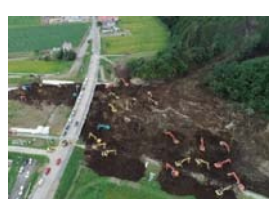
河道閉塞箇所において24時間体制で土砂撤去を実施 (北海道勇払郡厚真町・厚真川幌内橋付近)
