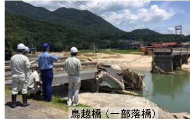
鳥越橋(一部落橋)
