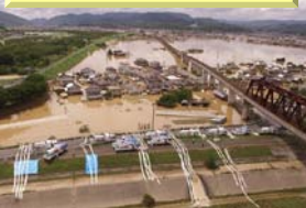
【H30.7月豪雨】 (岡山県倉敷市真備町)
