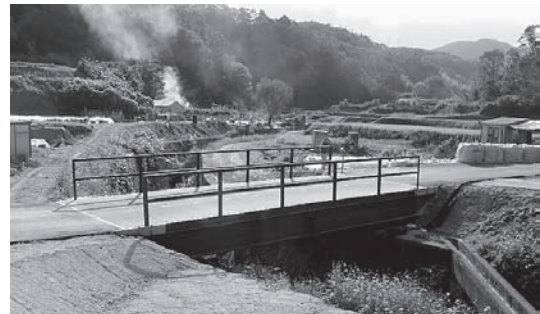
写真-3 仮橋設置後
