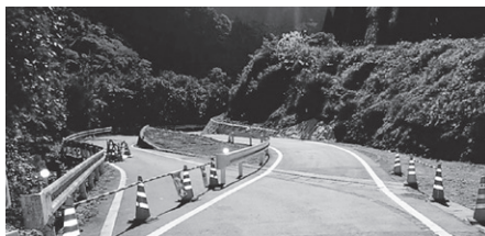
写真-1 仮道施工後
