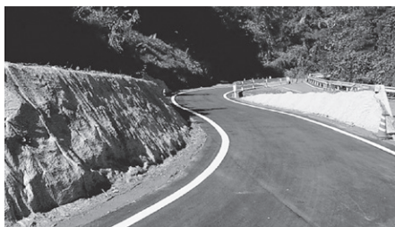
写真-2 仮道施工後
