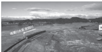
宮城県黒川郡大郷町粕川地先 鳴瀬川水系 吉田川 左岸20.9k 堤防決壊箇所 2019.10.13 7時53分時点
