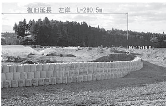
写真-1 仮締切の実施例
