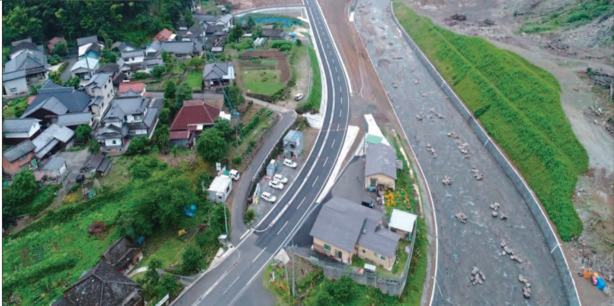
平成29年7月九州北部豪雨により右岸側山腹で大規模な斜面崩壊が発生し、河道と県道が被災した小野川 なぎの （ なぎの 柳野地区）の災害復旧工事が令和2年3月に完成しました。
