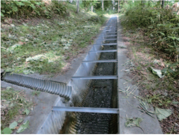
新設水路 (写真③)
