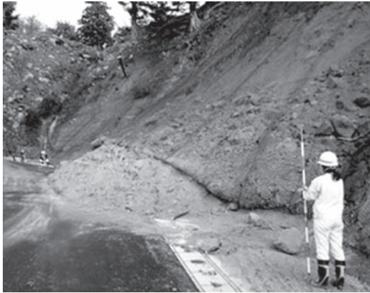
写真-1 崩落土災害の事例（台風19号）
